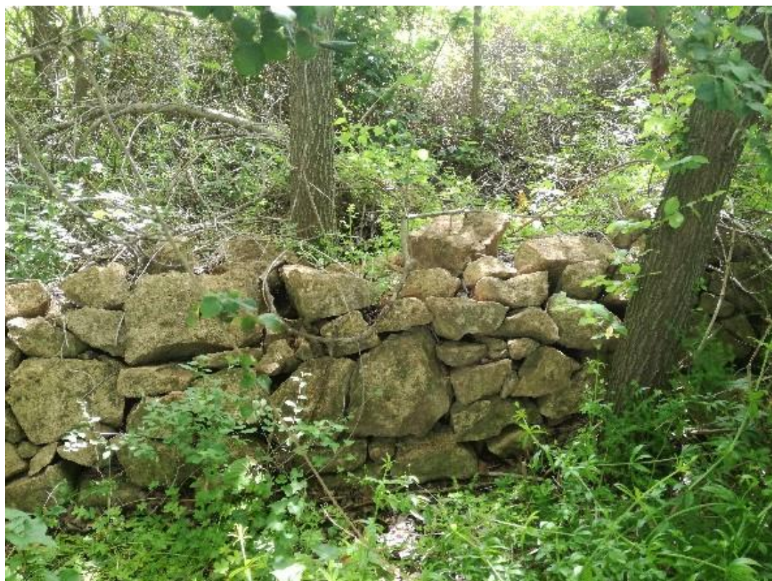
Figura 3 - Muretto di confine a secco
