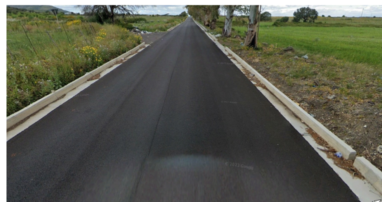
Interferenza 3 - Interferenza con la Strada Provinciale 95 , si propone il superamento mediante attraversamento con scavo a sezione obbligata
