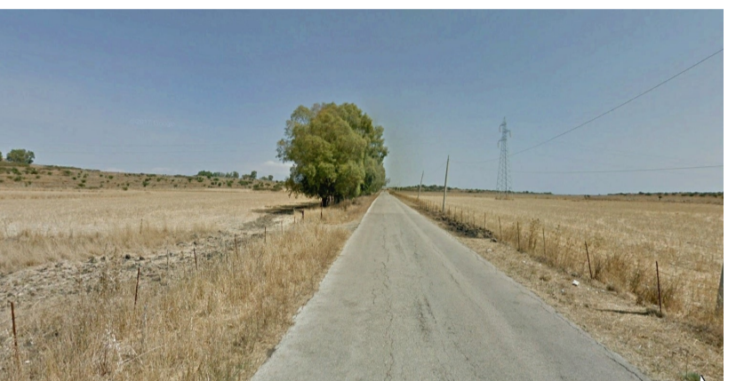
Interferenza 3 - Interferenza con la Strada Provinciale 9 , si propone il superamento mediante attraversamento con scavo a sezione obbligata
