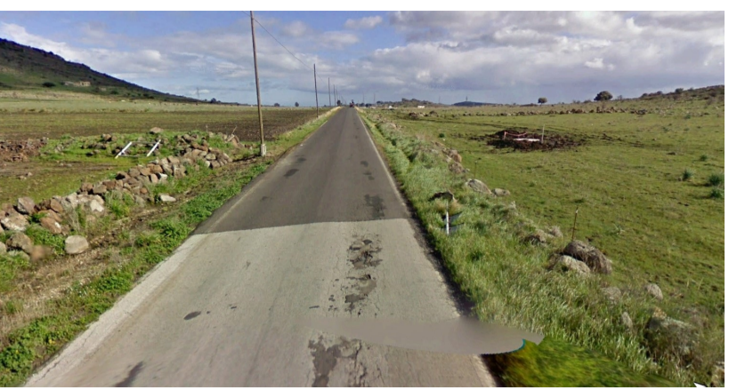
Interferenza 1 - Interferenza con la Strada Provinciale 32 , si propone il superamento mediante attraversamento con scavo a sezione obbligata
