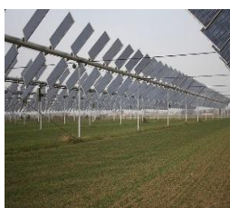
Impianti ad inseguimento biassiale su strutture elevate
