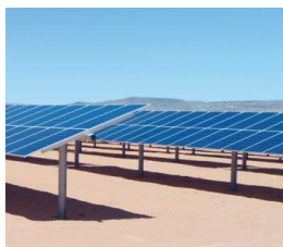
Impianto monoassiale (Inseguitore di rollio)
