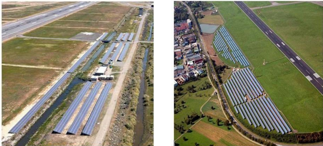
Figura 14 – Esempi di impianti fotovoltaici in ambito aeroportuale. La disposizione dei moduli fotovoltaici in prossimità delle piste di atterraggio/decollo non rappresenta un rischio per la sicurezza
