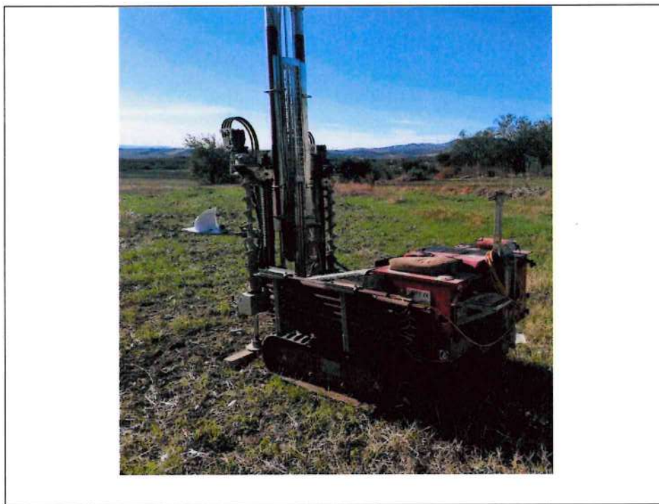
Esecuzione prova DPSH 9
