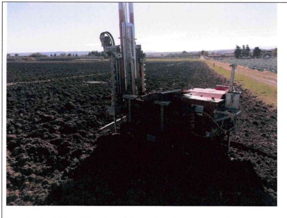
Esecuzione prova DPSH 4
