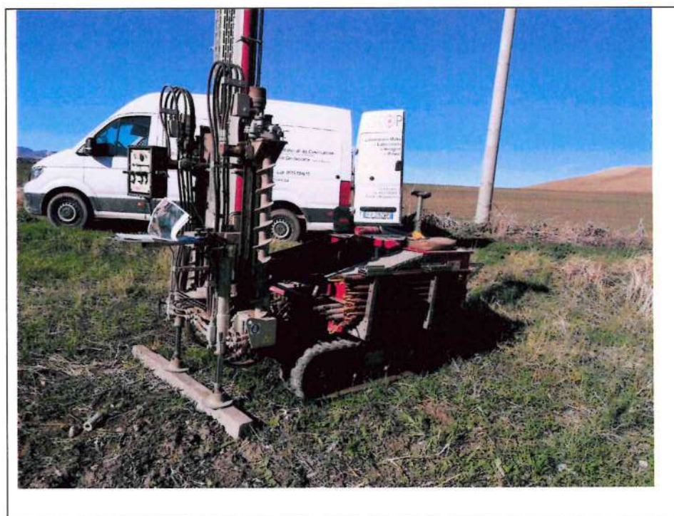
Esecuzione prova DPSH 10
