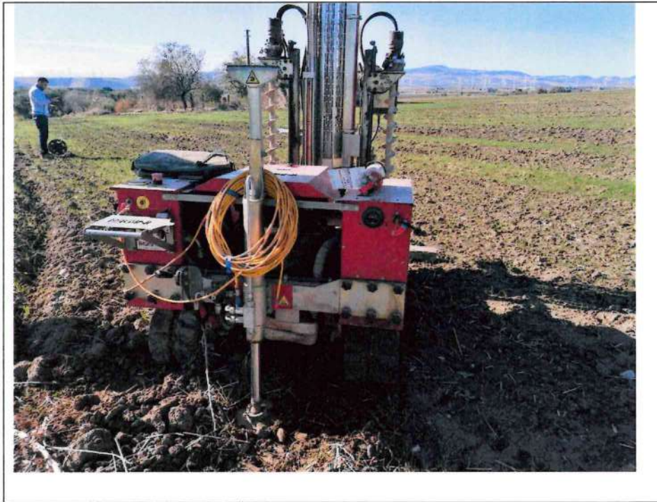
Esecuzione prova DPSH 7
