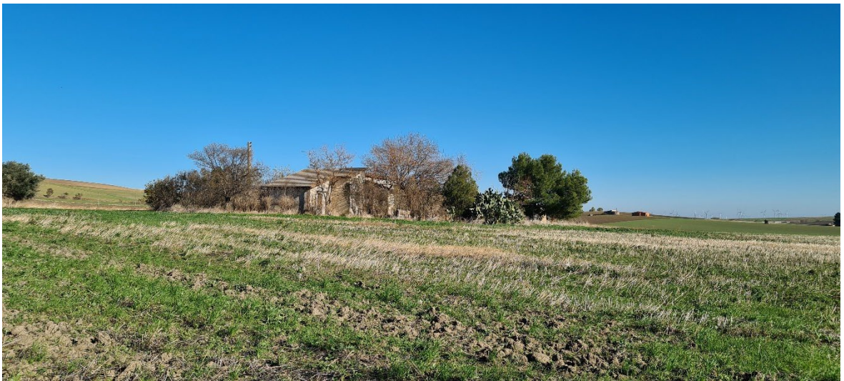
Foto 6: Insediamento agricolo in stato di abbandono (Lat. 41° 16' 29,25" - Long. 15° 30' 36,93")
