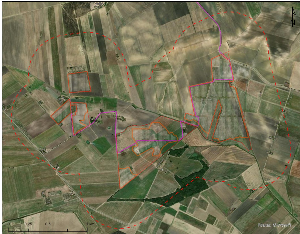
Figura 1: Impianto agrovoltaico Tamariceto (54,473 MWp).
