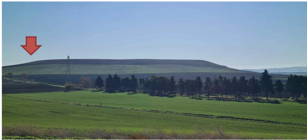
Punto di ripresa 01 da Chiesa di San Michele Arcangelo di Cisterna - POST OPERA
