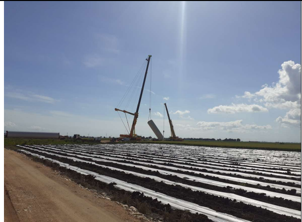
Esempio di sollevamento di tronco di torre (bottom)
