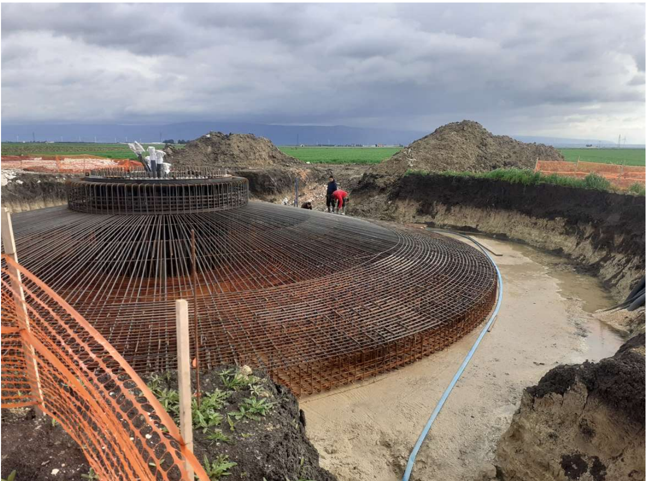
Fig. 23 Armatura di acciaio del plinto di fondazione.
