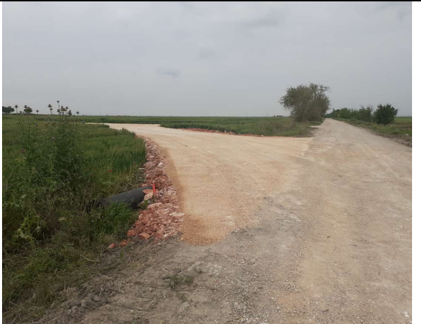
Esempio di area temporanea per allargamento
