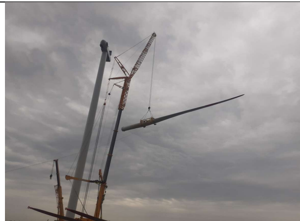
Esempio di sollevamento di blade
