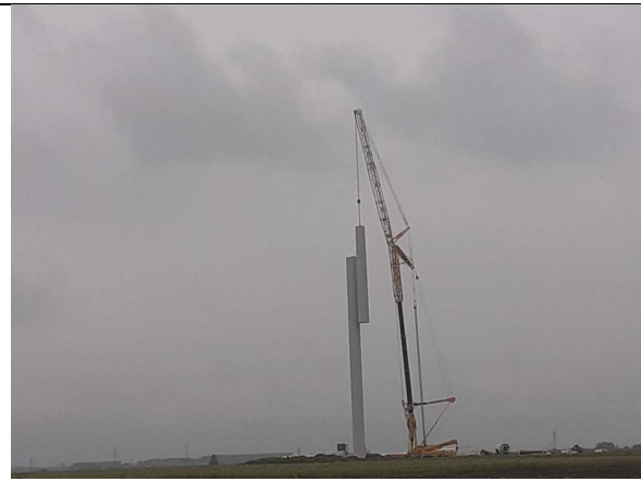
Esempio di sollevamento di tronco di torre (top)
