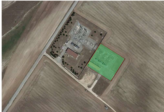
Fig. 4 Sottostazione di Spinazzola della EDISON RINNOVABILI S.P.A. (area di colore verde) A sinistra la SE-RTN di TERNA
