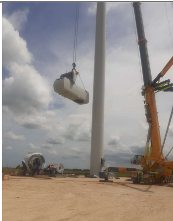
Esempio di sollevamento di navicella
