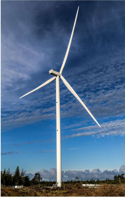
Fig. 13 Un aerogeneratore SGRE155 da 6,6 MW in esercizio
