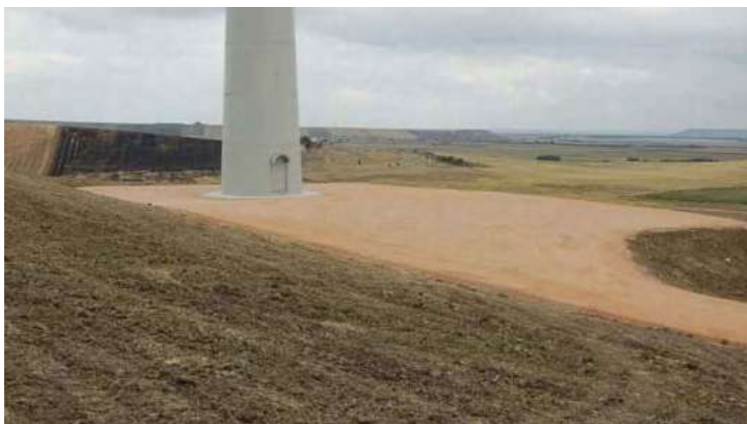
Fig. 24. Esempio di piazzola definitiva
