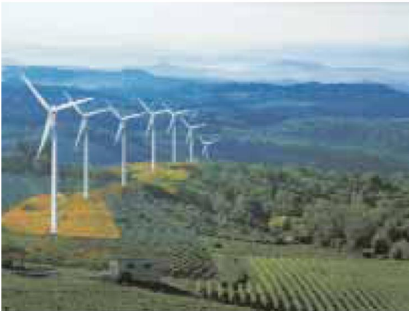
Fig. 44. Eolico e aree agricole: in un'area rurale molta attenzione dovrà essere posta per consentire la continuità nell'uso agricolo. Le infrastrutture accessorie andranno ridotte al minimo evitando frammentazioni dei campi, interruzioni di reti idriche, di strade e percorsi di comunicazione, ecc. Non dovranno essere realizzate costruzioni di altro tipo. È importante assicurare un aspetto uniforme ed il più possibile neutro e la disposizione delle macchine dovrà seguire le linee e i confini formali già presenti nel paesaggio.
