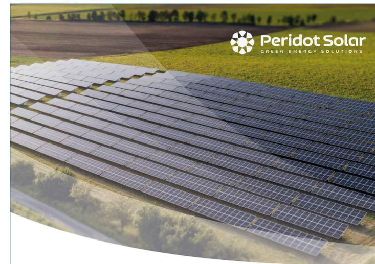
Progettazione definitiva finalizzata all'autorizzazione di una centrale di energia rinnovabile e delle relative opere di connessione denominata "Sperlinga", costituita da un impianto agrivoltaiico di potenza complessiva pari a 50,112 MW [DC] e potenza in immissione pari a 37,75128 MW [AC]. La centrale sarà realizzata in C.da Serravalle nel comune di Chiaromonte Gulfi (RG) - Sicilia
