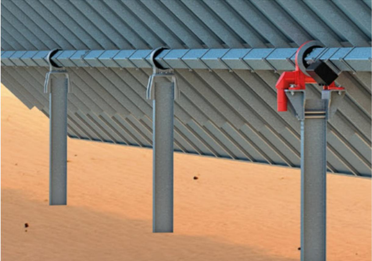
Come previsto dalle specifiche tecniche del sistema ad inseguimento solare considerato, le colonne a cui sarà fissata la trave continua rappresenta anche l'elemento di fondazione. Nel caso specifico, visto il tassativo divieto, da parte delle norme vigenti, di utilizzo di qualsiasi tipo di conglomerato cementizio per la realizzazione della fondazione, le colonne saranno infisse nel terreno di fondazione, mediante battitura diretta nel terreno.
