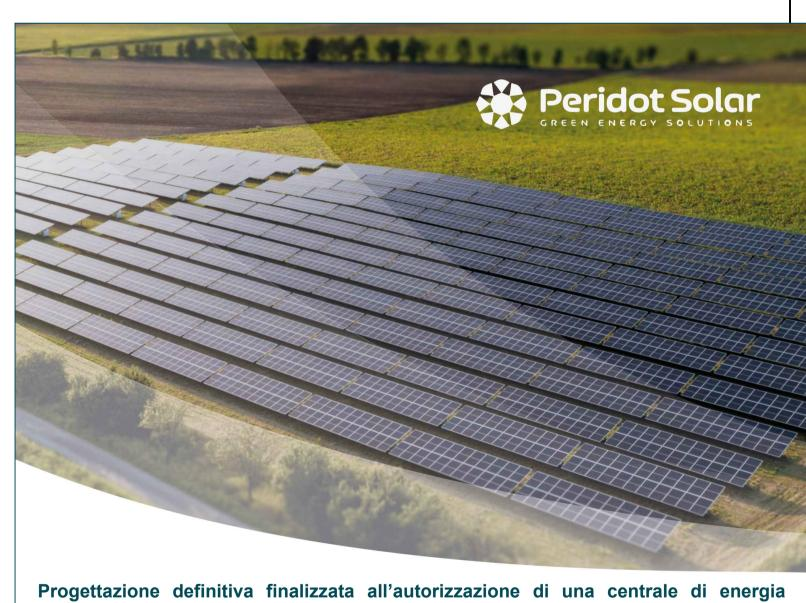
rinnovabile e delle relative opere di connessione denominata "Sperlinga", costituita da un impianto agrivoltaico di potenza complessiva pari a 50,112 MW [DC] e potenza in immissione pari a 37,75128 MW [AC]. La centrale sarà realizzata in C.da Serravalle nel comune di Chiaromonte Gulfi (RG) – Sicilia
