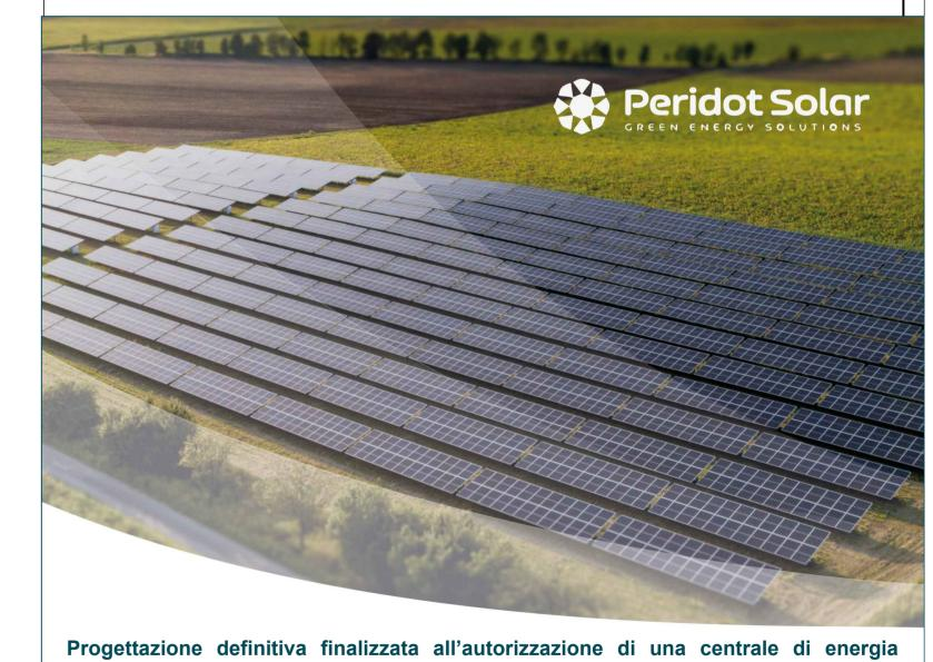
rinnovabile e delle relative opere di connessione denominata "Sperlinga", costituita da un impianto agrivoltaico di potenza complessiva pari a 50,112 MW [DC] e potenza in immissione pari a 37,75128 MW [AC]. La centrale sarà realizzata in C.da Serravalle nel comune di Chiaromonte Gulfi (RG) – Sicilia
