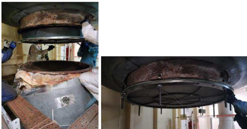
Figura 2.4 – foto dell'installazione del catalizzatore prototipo al camino E4
