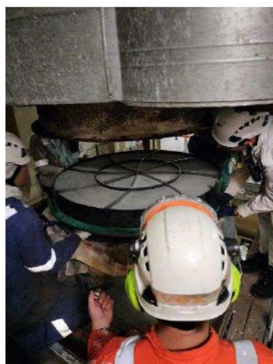
Figura 2.3 – foto del catalizzatore prototipo
