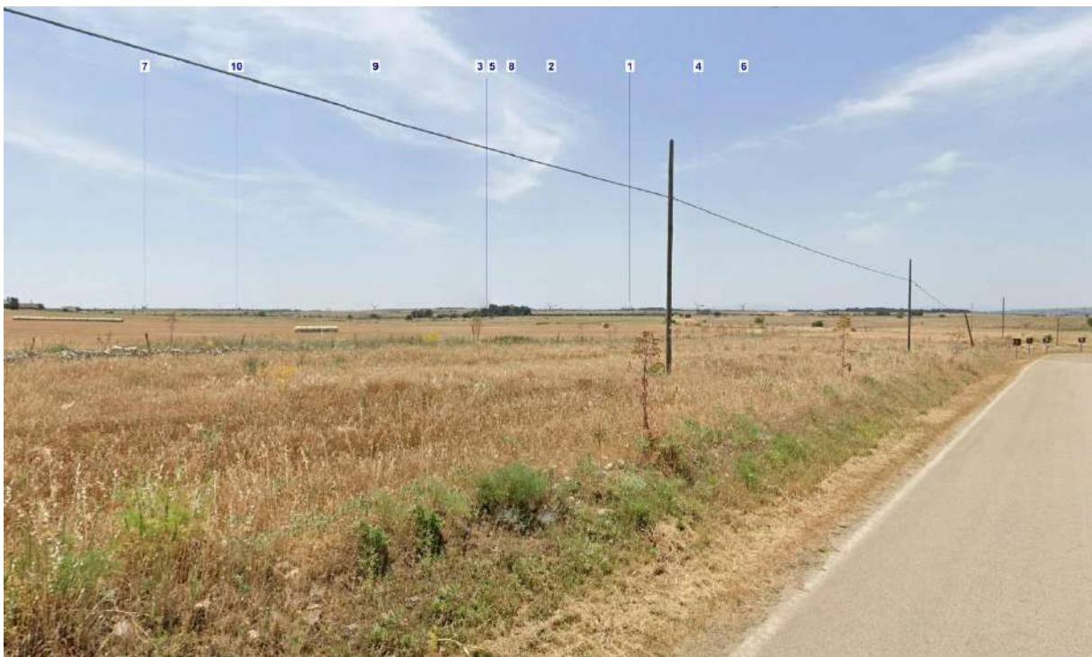
Figura 8-18 – PV04: sopra stato ante operam, sotto, stato post operam
