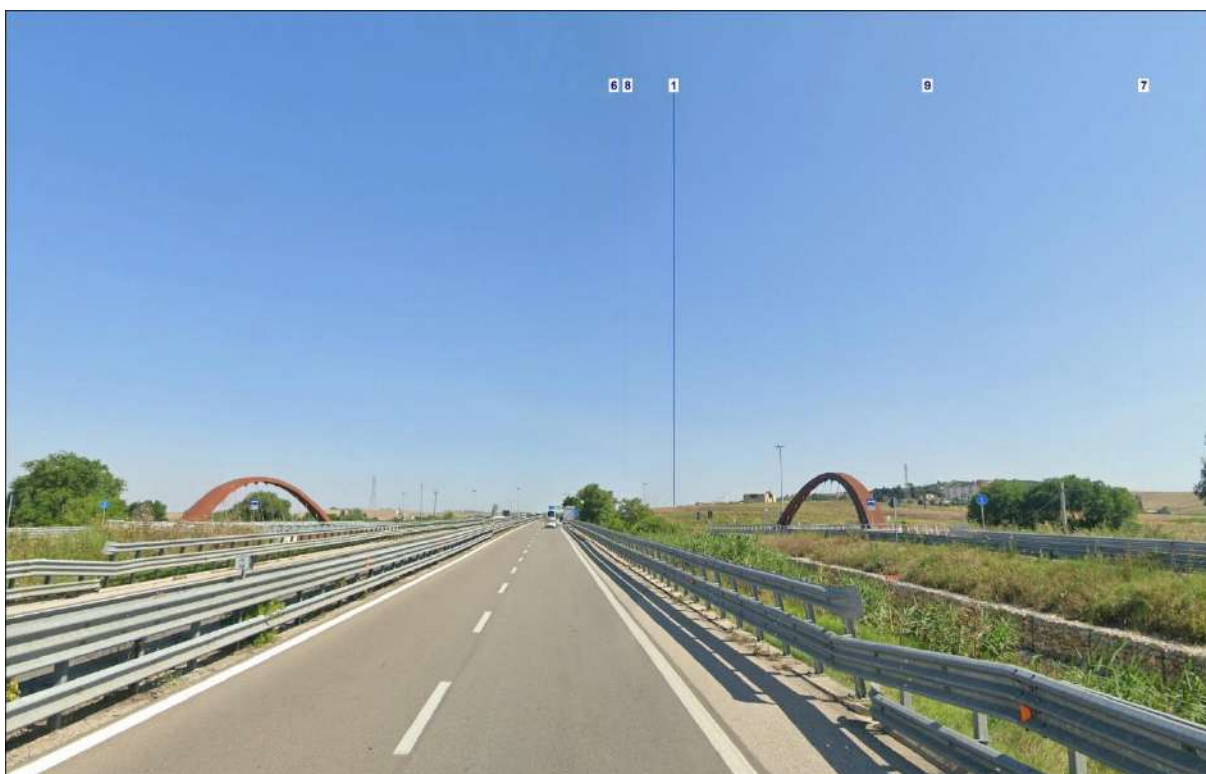
Figura 8-28 – PV08: sopra stato ante operam, sotto, stato post operam
