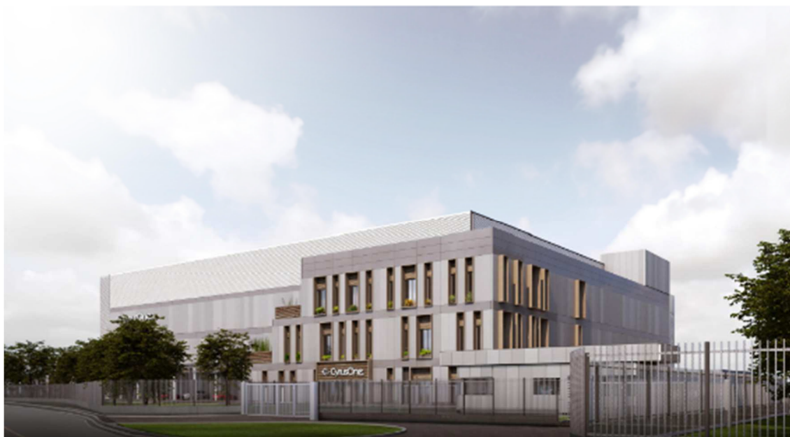
Figura 2.7: Vista esterna dell’Edificio 01
