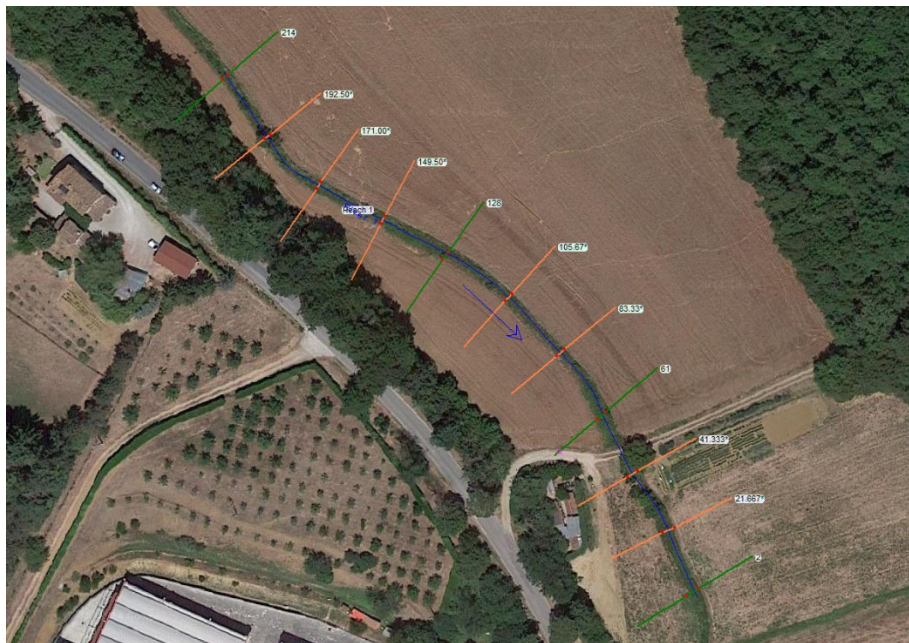
Figura 14 - Corso d'acqua IN02- Rio km 4+500 - Configurazione Ante Operam
