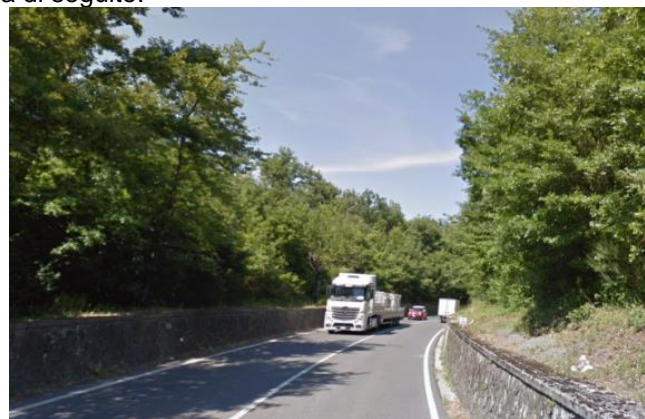
Figura 1.13 – condizioni di visibilità legate alla configurazione esistente fra prog. 6+800 e prog.7+120.
