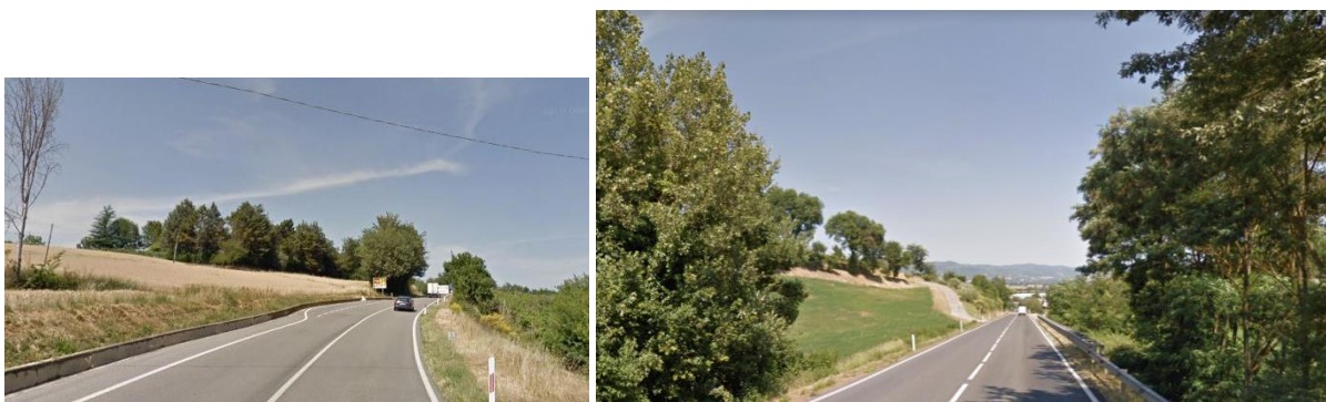
Figura 1.2 Sezione stradale esistente della S.S.73.
