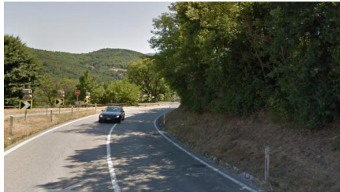
Figura 1.12 – condizioni di visibilità legate alla configurazione esistente fra prog. 1+800 e prog.1+970.
