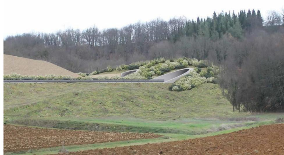
Figura 7-24 Fotoinserimento imbocco della galleria Citerna (imbocco ovest)
