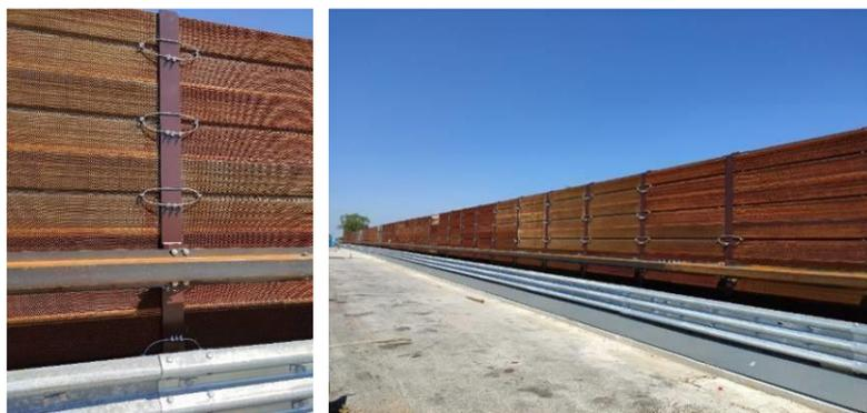
Figura 7-31 Immagine tipo di barriera acustica in acciaio corten con barriera stradale integrata
