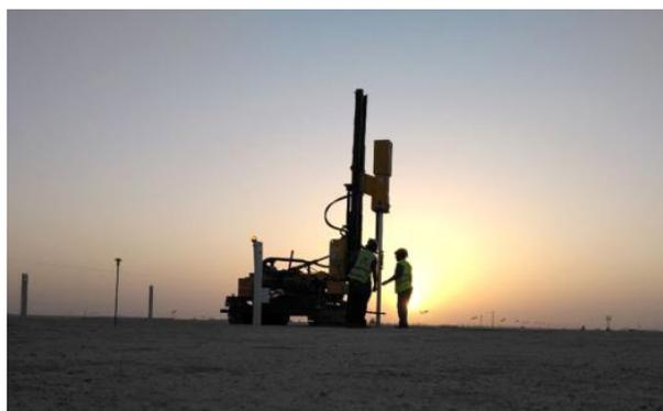
Una volta posizionati i pali di supporto, verrà poi eseguito il loro corretto allineamento e si potrà procedere al montaggio delle parti fisse di cornice, e successivamente al montaggio e collegamento dei pannelli fotovoltaici da essi movimentati.
