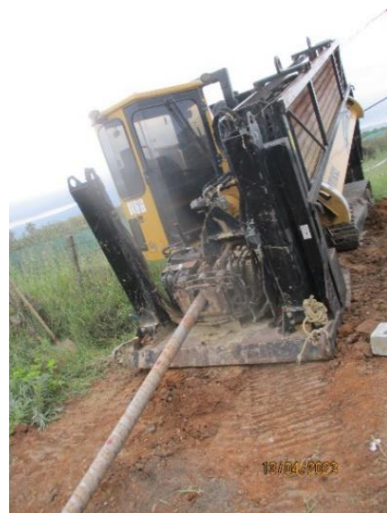
Macchina per infilaggio talpa e tubi sonda
