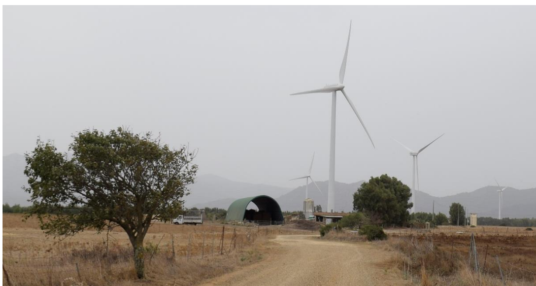
Foto Sopralluogo 7 - Area adiacente a quella di intervento in data 18/09/2023 (S.Mocci)
