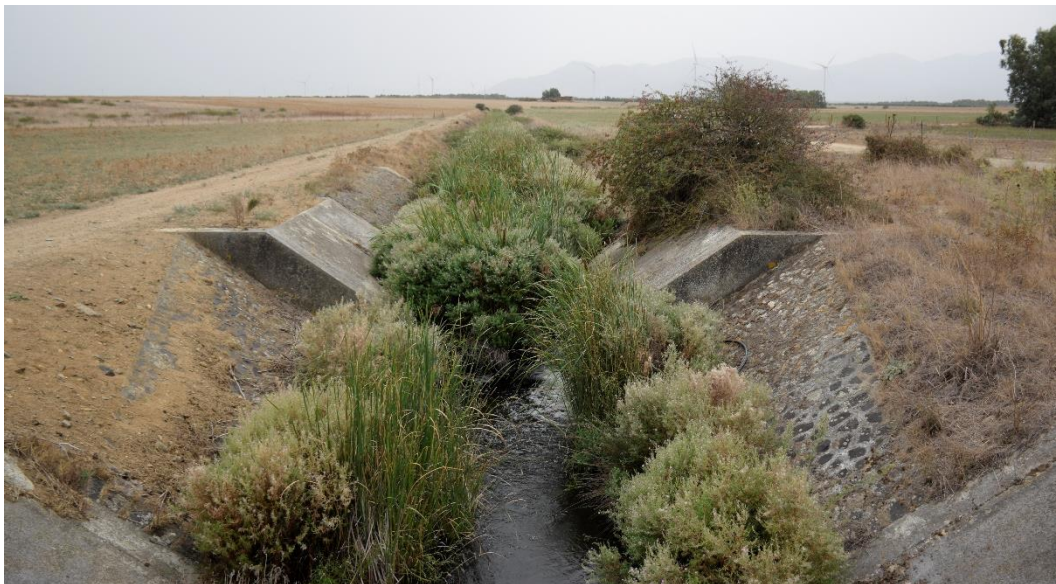
Foto Sopralluogo 7 - Stato dell'area di intervento in data 18/09/2023
