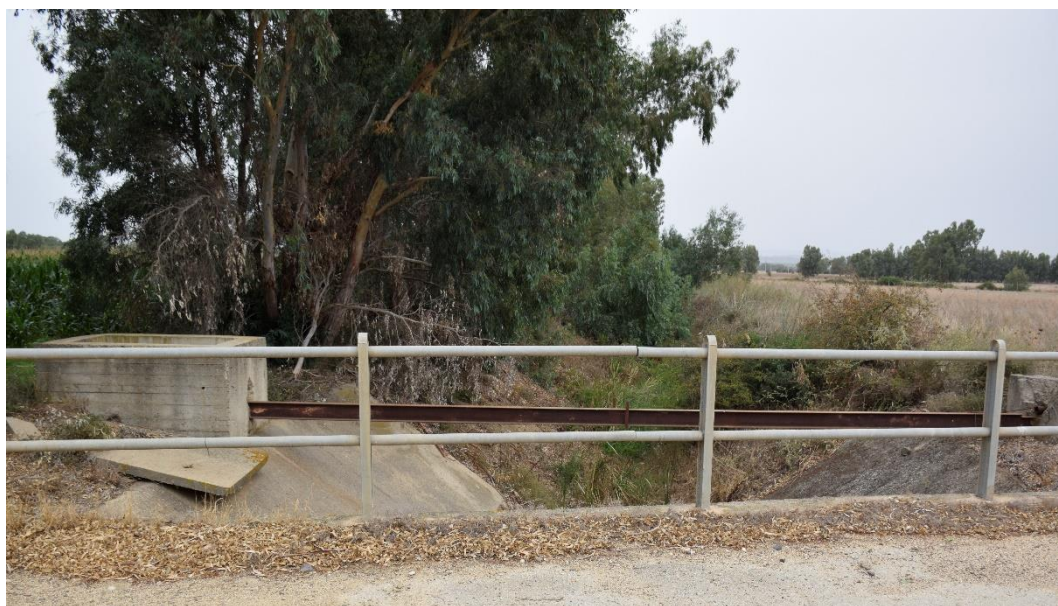
Foto Sopralluogo 6 - Stato dell'area di intervento in data 18/09/2023
