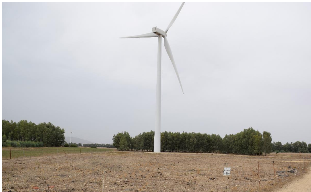
Foto Sopralluogo 10 – Area di intervento in data 18/09/2023 (S.Mocci)
