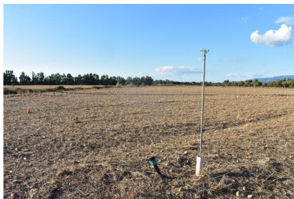
Figura 37 – Dettaglio dell'impianto irriguo
