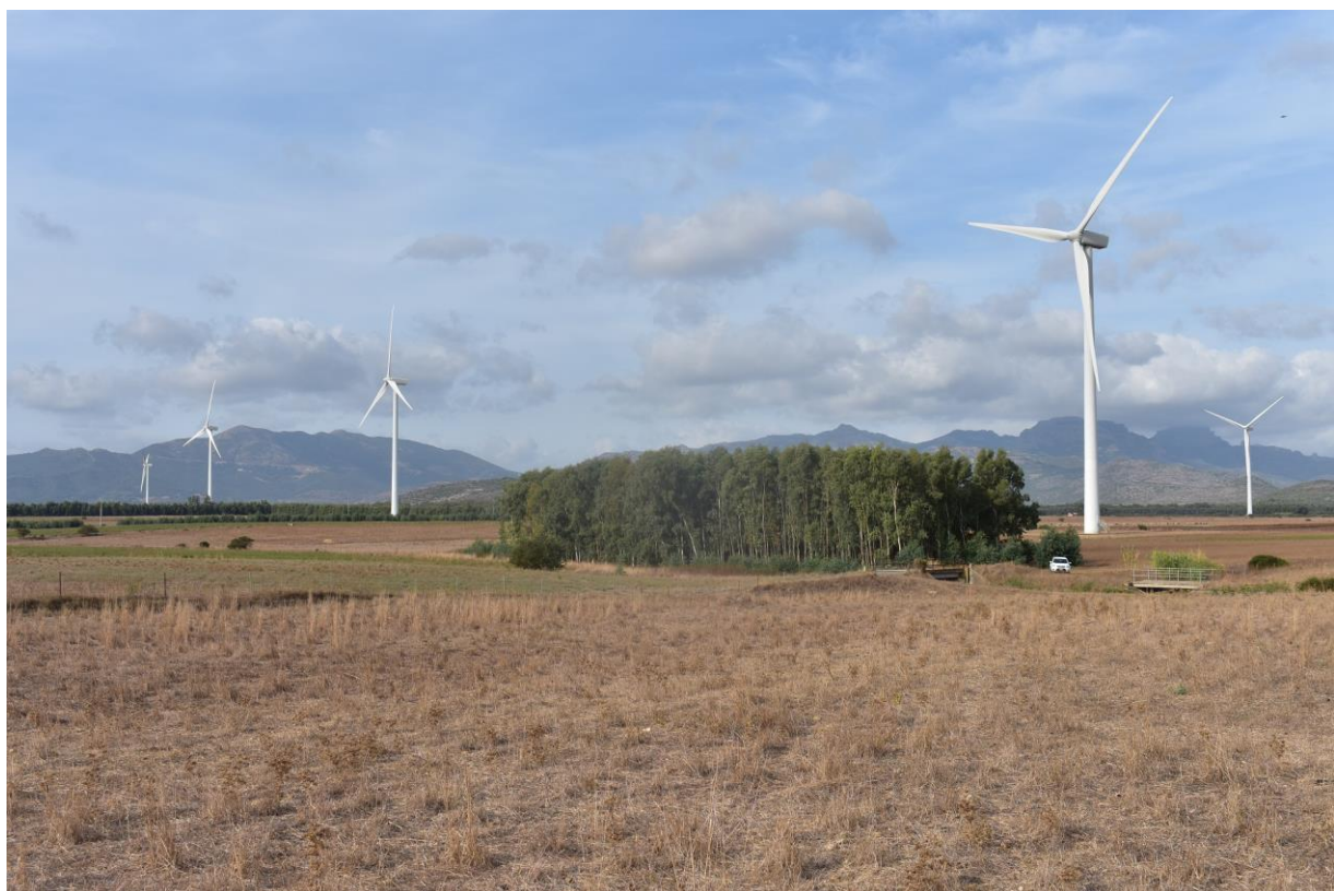
Figura 4 - Vista in direzione ovest delle superfici in cui si prospetta l'installazione dei tracker
