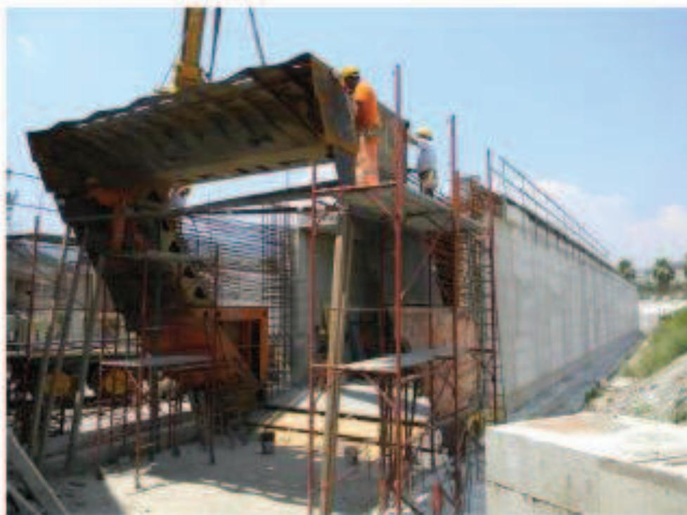
Figura 7: Montaggio dello scudo
