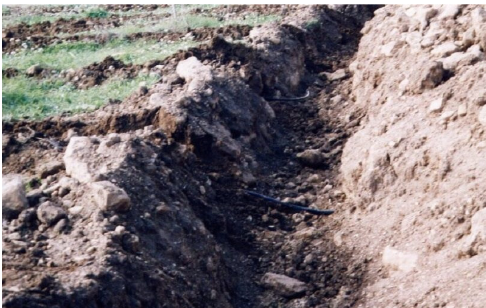
Posa delle tubazioni interrate (Maniscalco irrigazioni)
