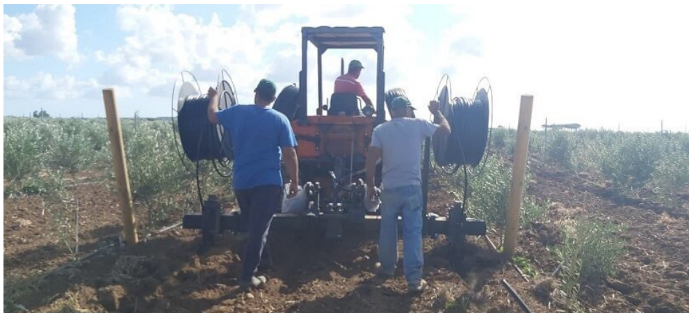
Posa delle tubazioni interrate (Maniscalco irrigazioni)
