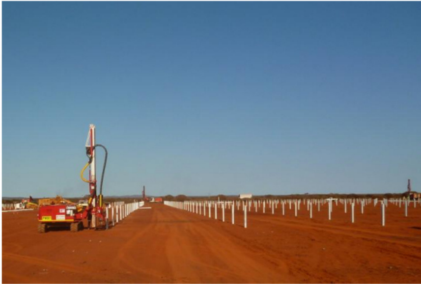
Fig.7: Infissione sostegni verticali strutture
