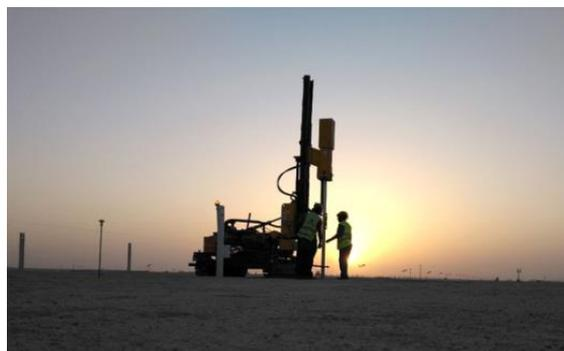
Una volta posizionati i pali di supporto, verrà poi eseguito il loro corretto allineamento e si potrà procedere al montaggio delle parti fisse di cornice, e successivamente al montaggio e collegamento dei pannelli fotovoltaici da essi movimentati.
