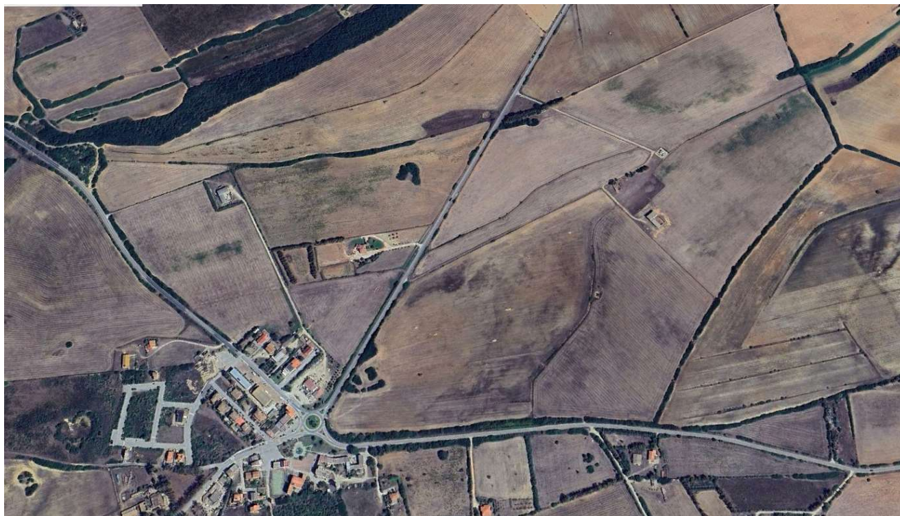
Foto 1 – panoramica Ante Operam
