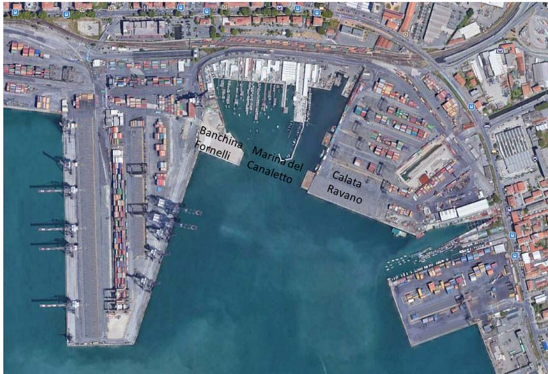
Figura 2.1. Vista dell'area di intervento prima della rimozione delle infrastrutture presenti
