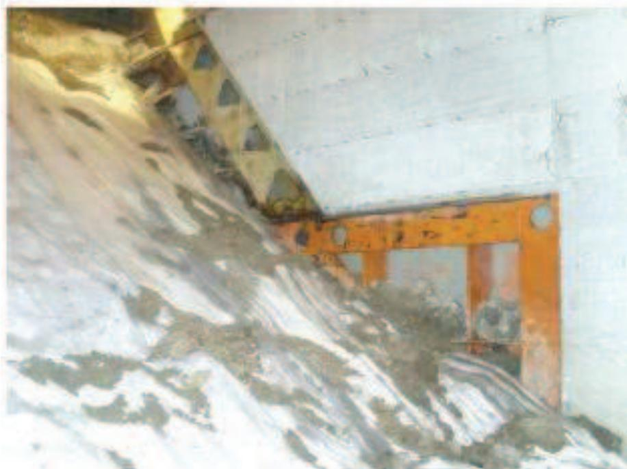
Figura 9: Messa in sicurezza e protezione del fronte di scavo per una pausa lunga
