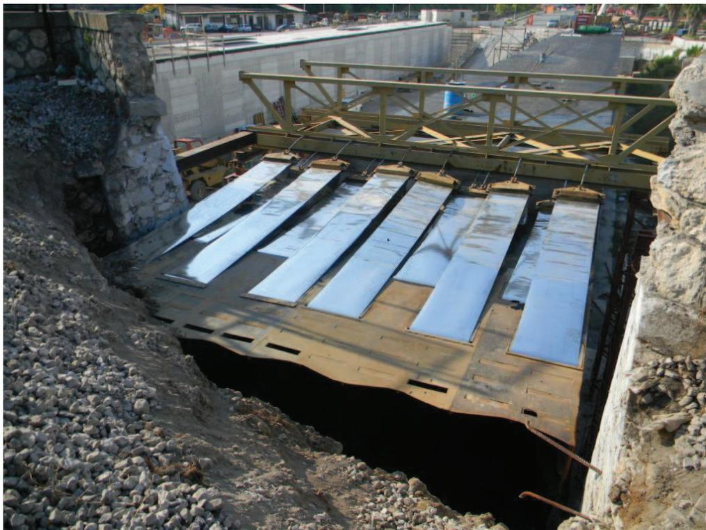
Figura 4: Svolgimento dei nastri di trascinamento a inizio infissione
