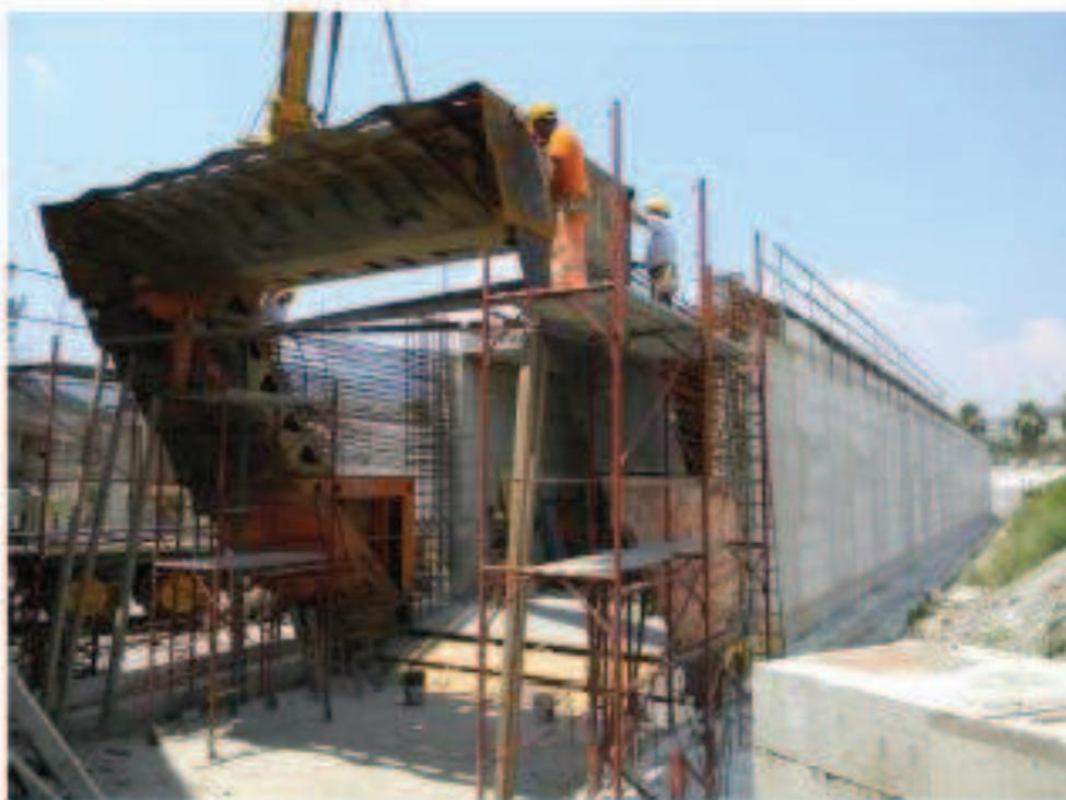
Figura 7: Montaggio dello scudo
