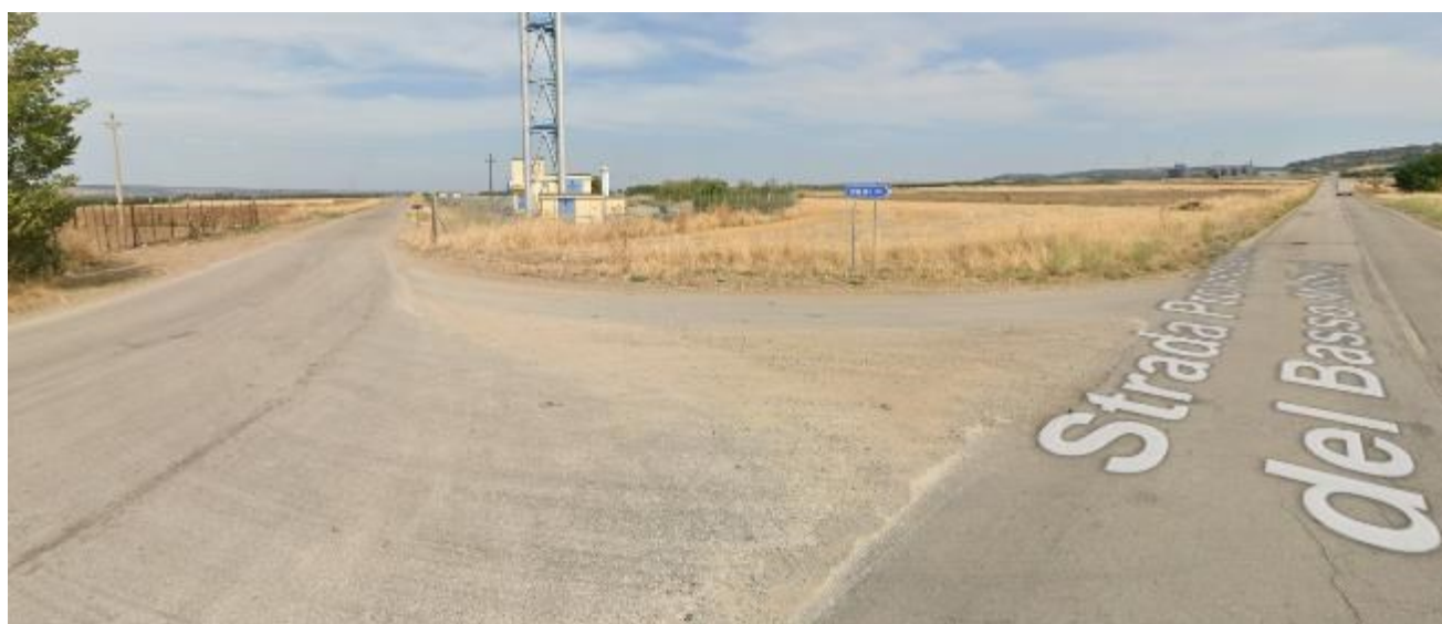
Figura 42 – Ripresa fotografica in prossimità del punto di interferenza del cavidotto interrato esterno di progetto con il tratturello: il cavidotto seguirà la viabilità esistente
