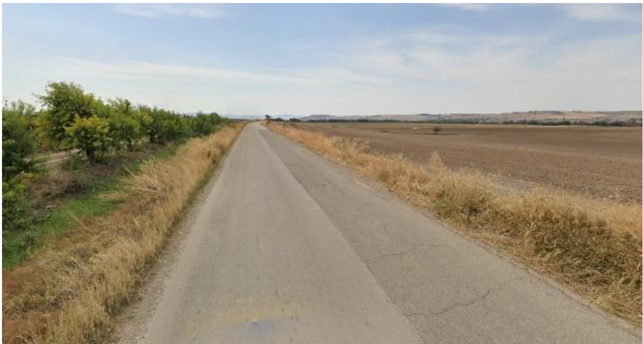
Figura 34 – Interferenza del tracciato del cavidotto interrato tra WTG01 e WTG02 con tratturello e scatto fotografico dello stesso in prossimità del punto interessato
