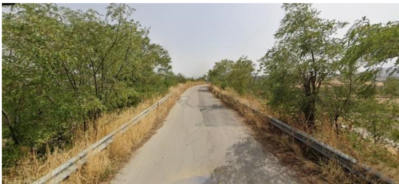
Figura 54 – Scatto fotografico su viabilità esistente, in prossimità dell’area mappata come “area boscata”: il cavidotto seguirà la viabilità esistente
