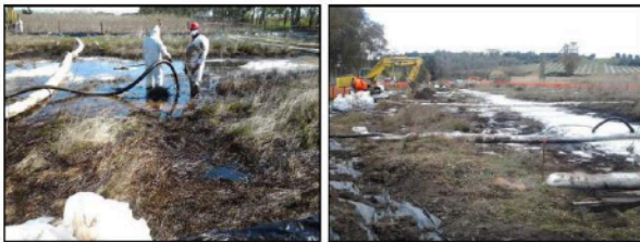
Fig. 10 A,B - Sversamento di petrolio sul suolo per rottura dell'oleodotto che trasporta il petrolio della Val d'Agri alla raffineria di Taranto. (Foto di P. Acito)
