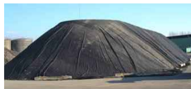
3 Copertura con i teli
