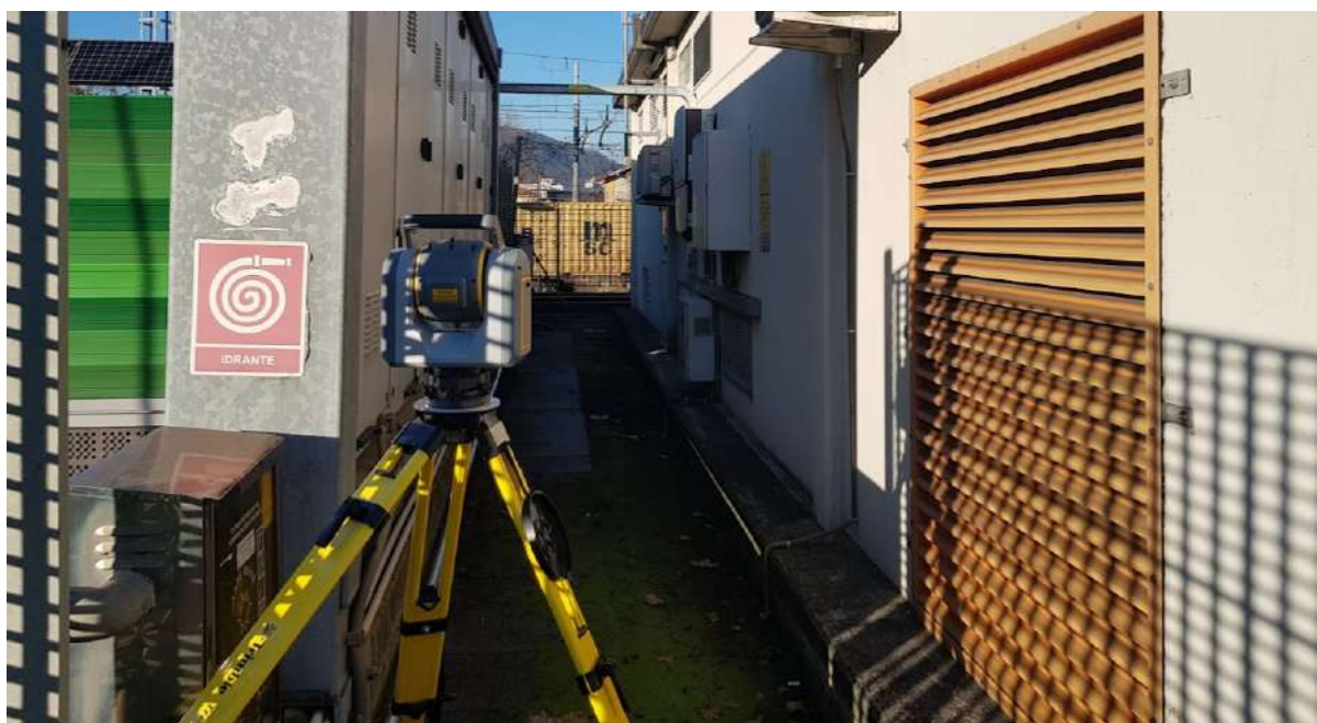
Rilievo laser scanner della cabina di trasformazione in corrispondenza dell'accesso Ovest della galleria Subalvea
