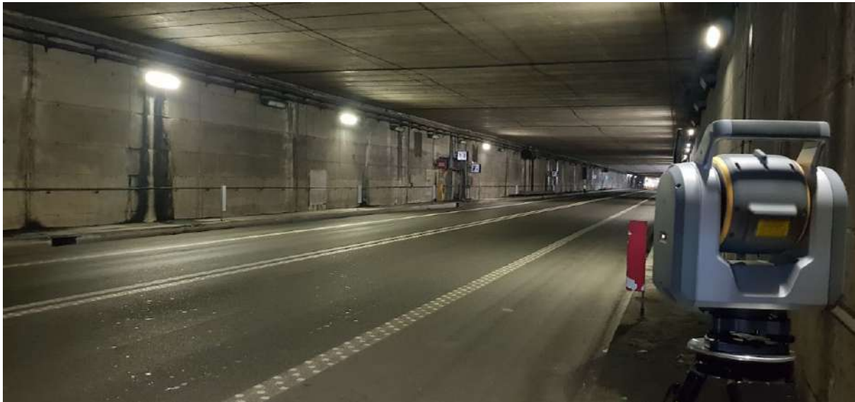
Rilievo laser scanner all'interno della galleria Subalvea
