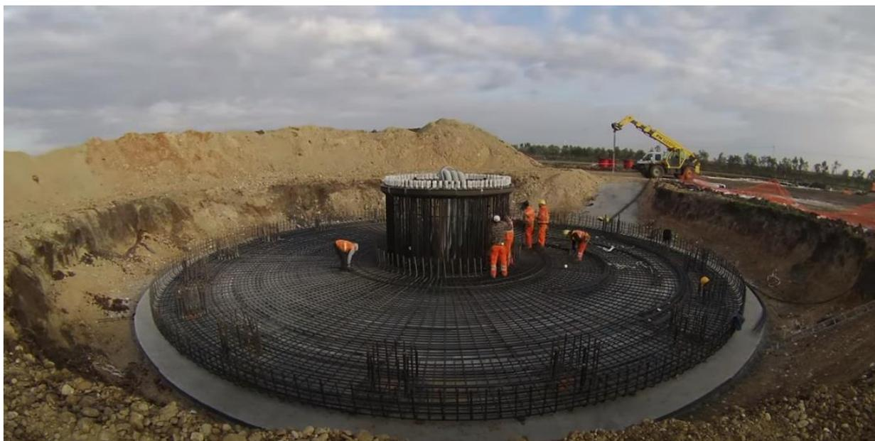
Figure 15 - Predisposizione del plinto di fondazione
