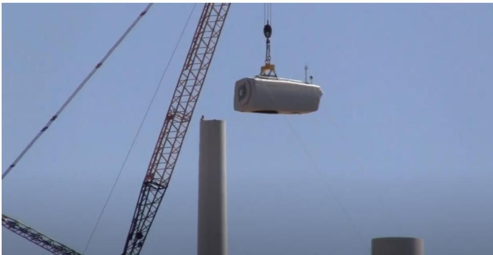
Figure 17 - Installazione navicella
