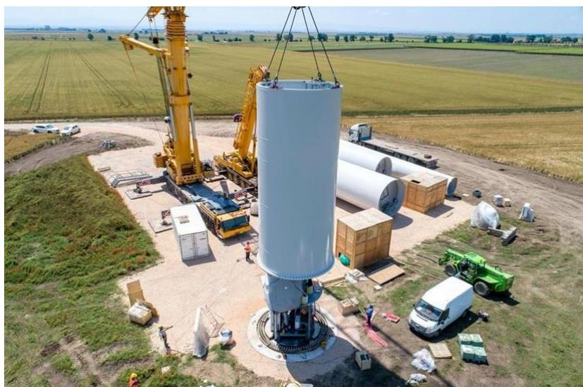
Figure 16 - fissaggio al basamento della fondazione
