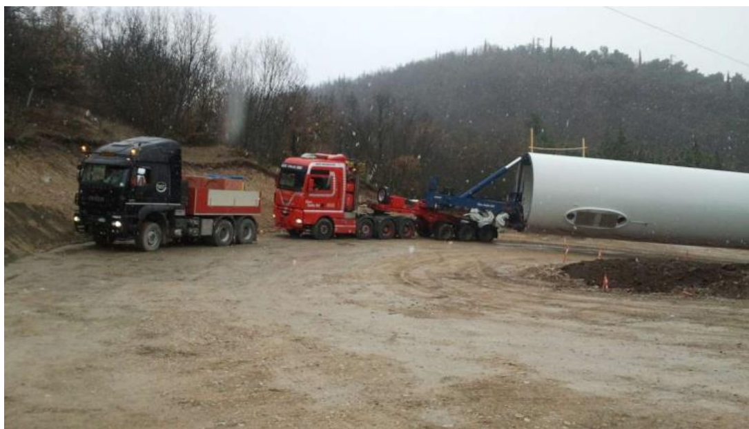
Figure 7 - Esempio di traino durante il cantiere
