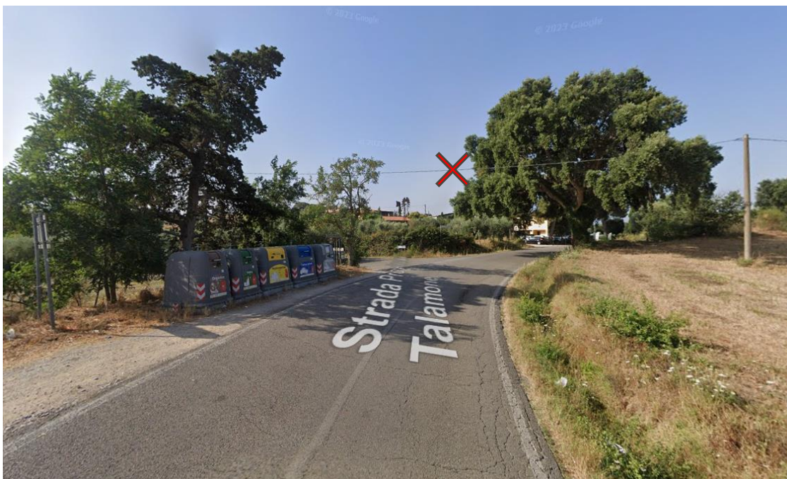
Figure 67 - Stato di fatto sito intervento 56 a
