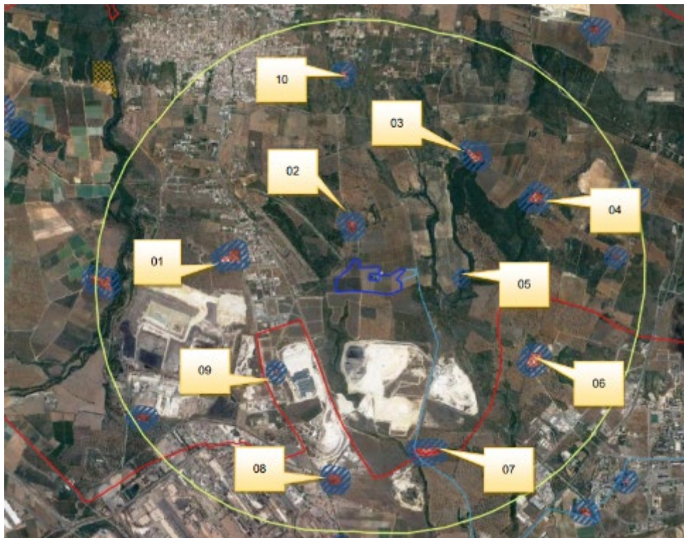
Figura 20 – Fulcri visivi all'interno dell'area di indagine (3km dal l'impianto) - Individuazione di BP e UCP nell'area di intervento con le relative aree di rispetto. Da: AM04_REL_PAESAGGISTICA.pdf. Pag. 68
