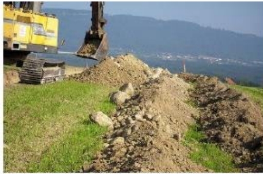
Figura 42 Modalità di apertura e chiusura scavi in aree agricole
