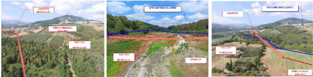
Figura 6 Superamento attraversamento Torrente Cervaro – Strada Comunale Guardialfiera Contini Palata (TOC n.2)
