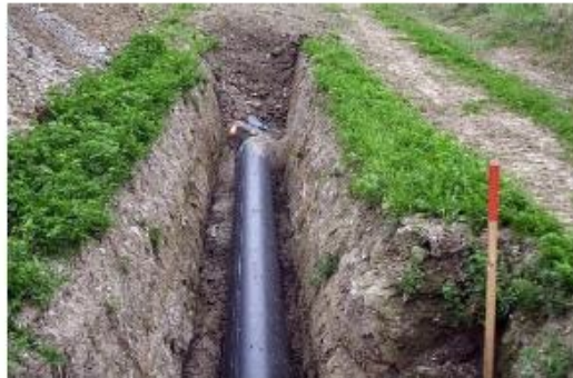
Figura 42 Modalità di apertura e chiusura scavi in aree agricole
