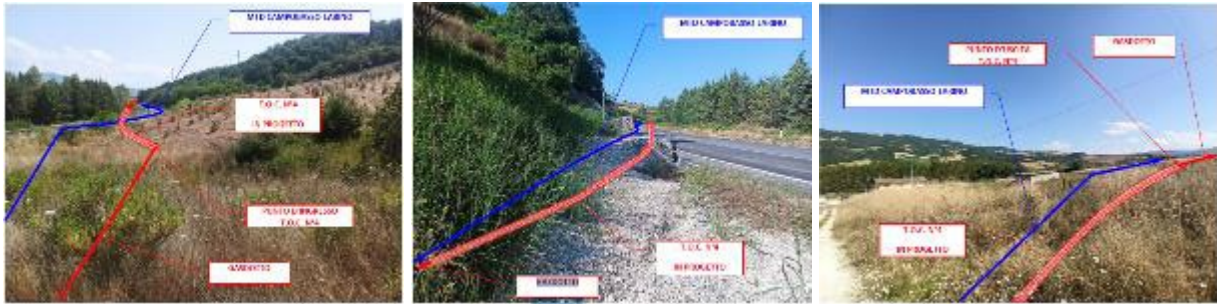
Figura 8 Attraversamento parallelismo strada comunale ex Bifernina con TOC n.4
