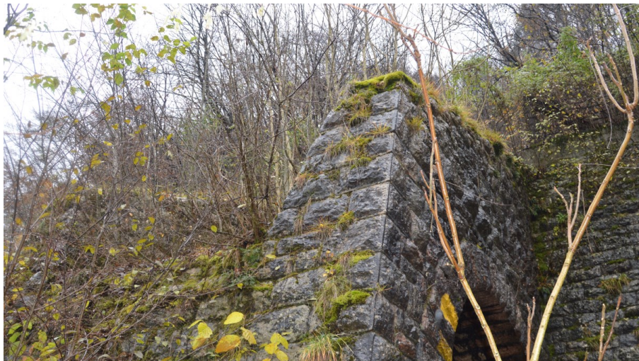
Figura 3: IV02 - Scivolo legnami 134+610 – Prospetto laterale, parte alta
