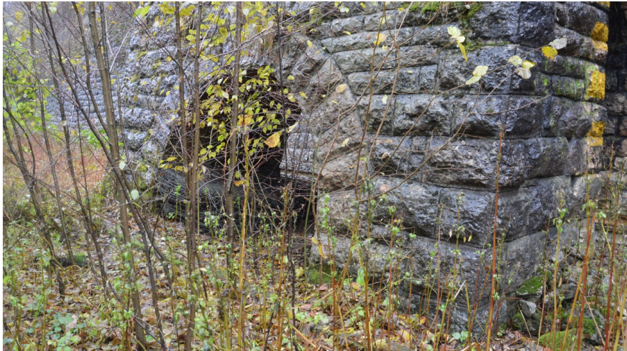
Figura 4: IV02 - Scivolo legnami 134+610 – Prospetto laterale, parte bassa
