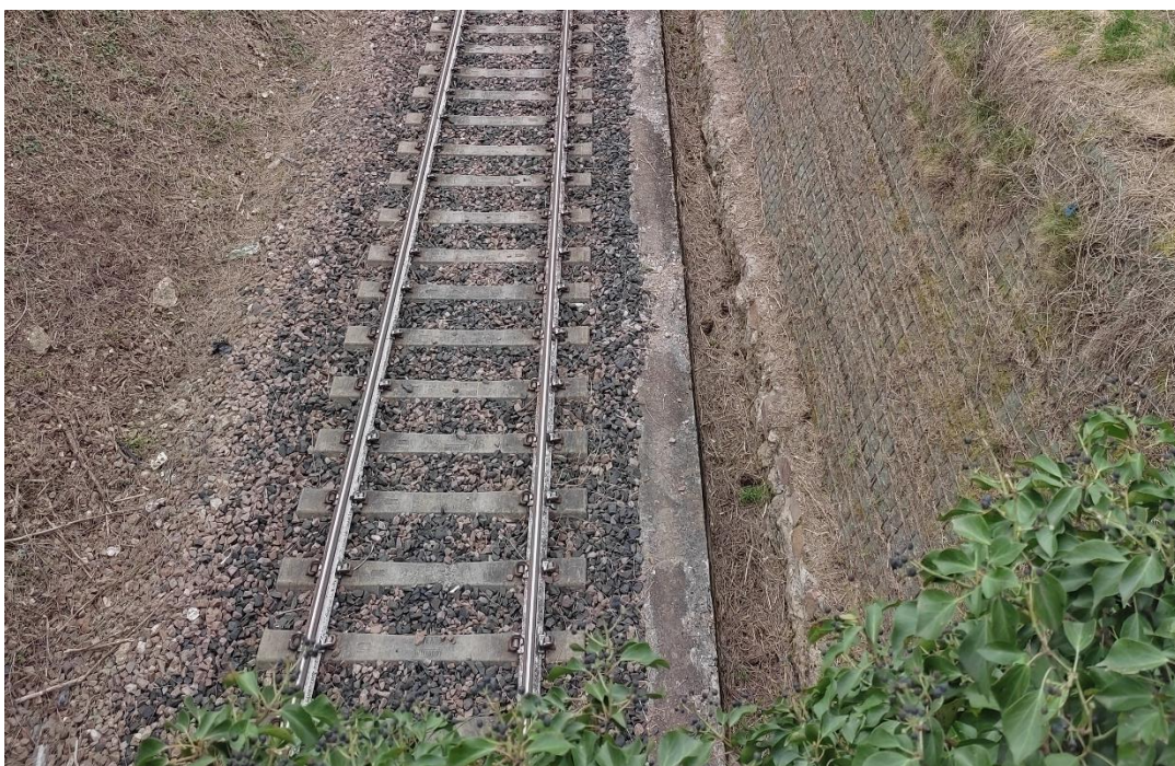
Figura 7.1: Canaletta di evacuazione acque esistente
