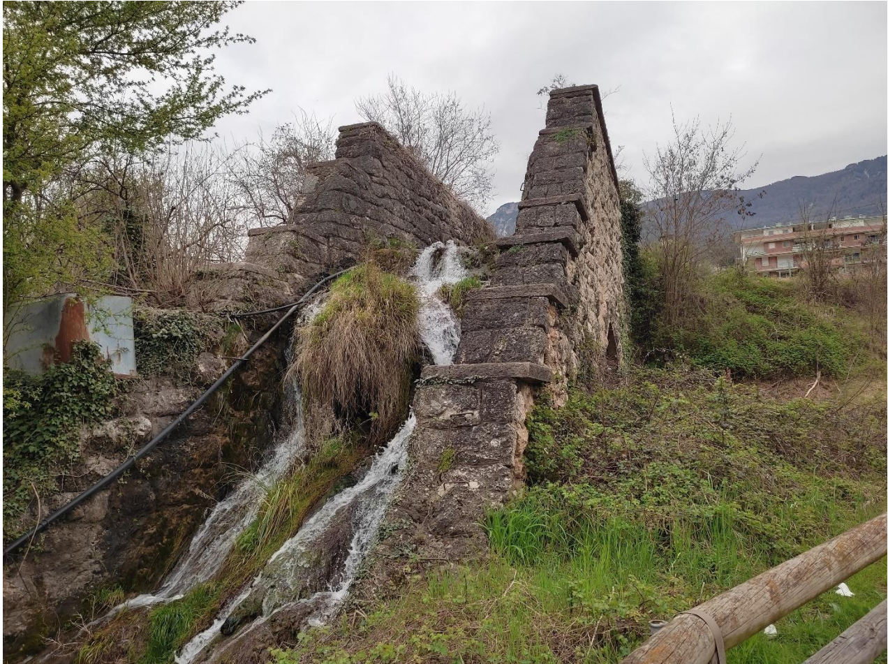
Figura 7.10: il ponte canale pkm 143+201
