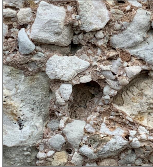
Figura 15 – VI01 – Viadotto Gocciadoro: conglomerato naturale roccioso costituente i blocchi di pietra [foto da sopralluogo ITALFERR del 28 Luglio 2022]
