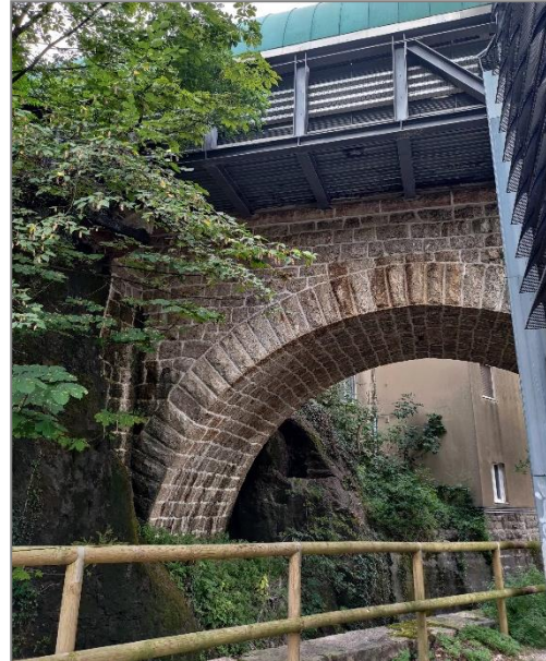
Figura 11 – VI01 – Viadotto Gocciadoro: vista dell'interferenza del Viadotto, nel tratto lato Bassano del Grappa, con il Torrente Salè in corrispondenza della Stazione di S. Chiara (vista lato sud foto di sx e vista lato nord foto di dx) [foto da sopralluogo ITALFERR del 28 Luglio 2022]
