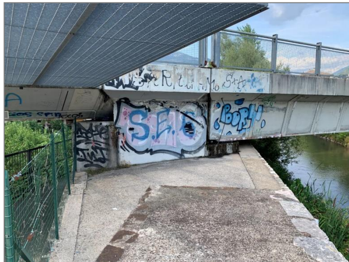
Figura 20 – VI01 – Viadotto Gocciadoro: manufatto in c.a. afferente al Torrente Fersina e via Cauriol (lato Sud) interessato dalla posa del palo della tipologia LSU-18S [foto da sopralluogo ITALFERR del 28 Luglio 2022]
