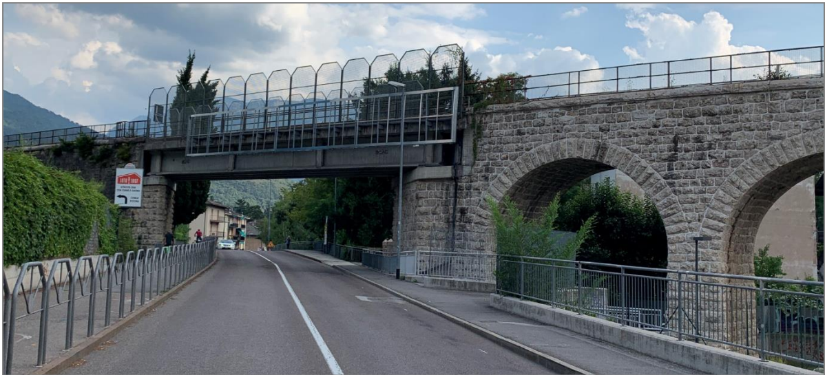
Figura 9 – VI01 – Viadotto Gocciadoro: vista lato nord dell'interferenza del Viadotto, nel tratto lato Bassano del Grappa, con viale Verona [foto da sopralluogo ITALFERR del 28 Luglio 2022]
