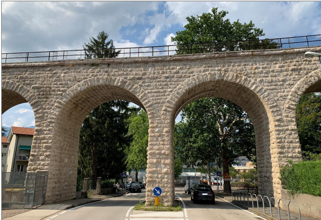
Figura 10 – VI01 – Viadotto Gocciadoro: vista lato sud dell'interferenza del Viadotto, nel tratto lato Bassano del Grappa, con via Gocciadoro [foto da sopralluogo ITALFERR del 28 Luglio 2022]
