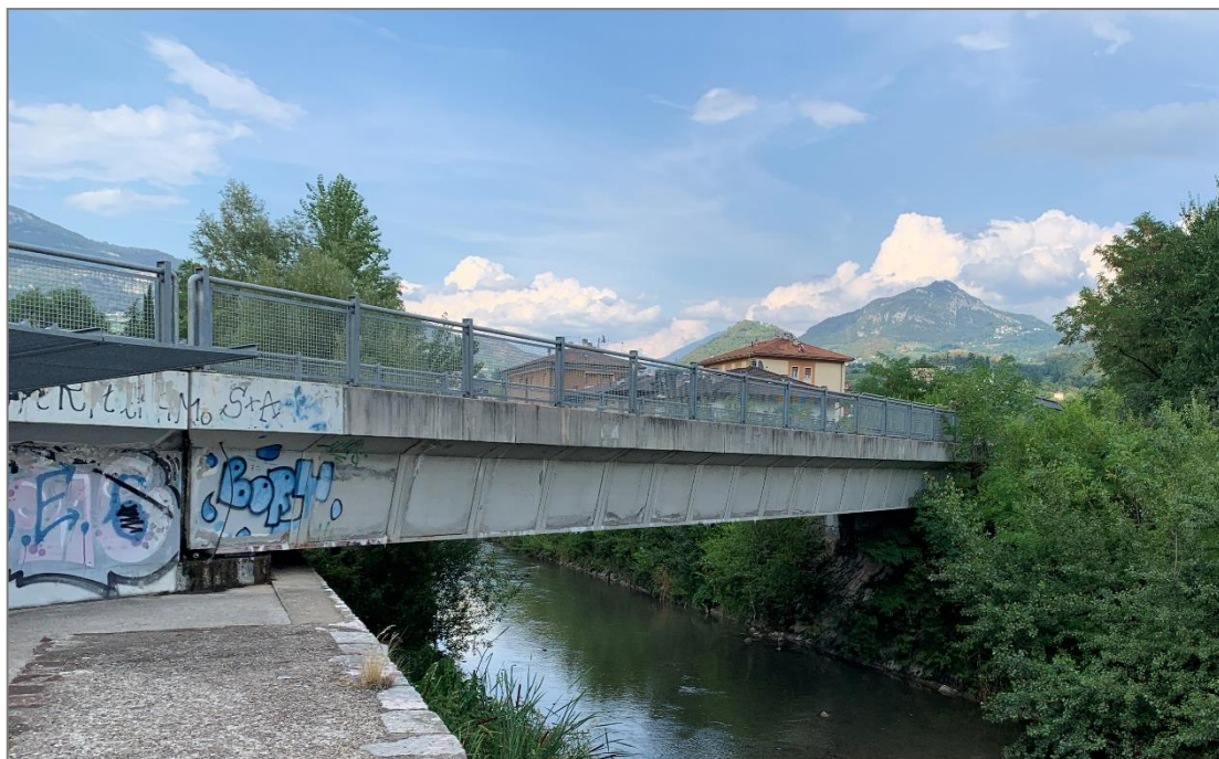
Figura 8 – VI01 – Viadotto Gocciadoro: vista lato sud dell'interferenza del Viadotto, nel tratto lato Trento, con il Torrente Fersina [foto da sopralluogo ITALFERR del 28 Luglio 2022]
