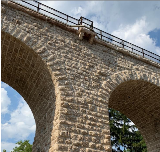
Figura 14 – VI01 – Viadotto Gocciadoro: blocchi di pietra costituenti gli elementi murari del Viadotto [foto da sopralluogo ITALFERR del 28 Luglio 2022]
