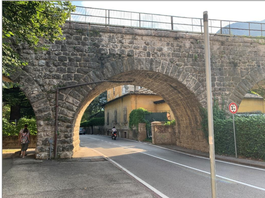
Figura 5 – VI01 – Viadotto Gocciadoro: vista lato nord dell'interferenza del Viadotto, nel tratto lato Trento, con via dei Muredei [foto da sopralluogo ITALFERR del 28 Luglio 2022]
