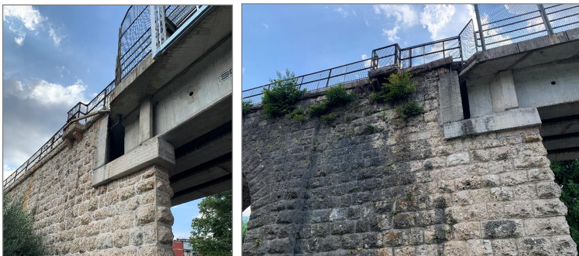
Figura 21 – VI01 – Viadotto Gocciadoro: attraversamento di viale Verona spalla lato Trento (lato Sud) interessata dalla posa del palo della tipologia LSU-18S (foto sx) e spalla lato Bassano del Grappa (lato Nord) interessata dalla posa del palo della tipologia LSU-22S (foto dx) [foto da sopralluogo ITALFERR del 28 Luglio 2022]
