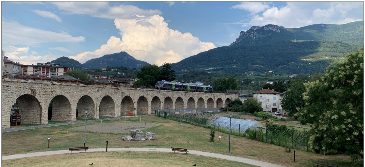
Figura 4 – VI01 – Viadotto Gocciadoro: vista di insieme di una parte del Viadotto, nel tratto lato Bassano del Grappa, in corrispondenza del Giardino Alexander Lager [foto da sopralluogo ITALFERR del 28 Luglio 2022]
