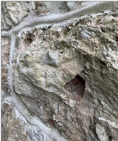
Figura 15 – VI01 – Viadotto Gocciadoro: conglomerato naturale roccioso costituente i blocchi di pietra [foto da sopralluogo ITALFERR del 28 Luglio 2022]
