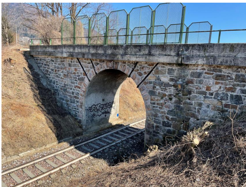
Figura 6:: Sovrappasso al km 117+362 Levico – Stato attuale
