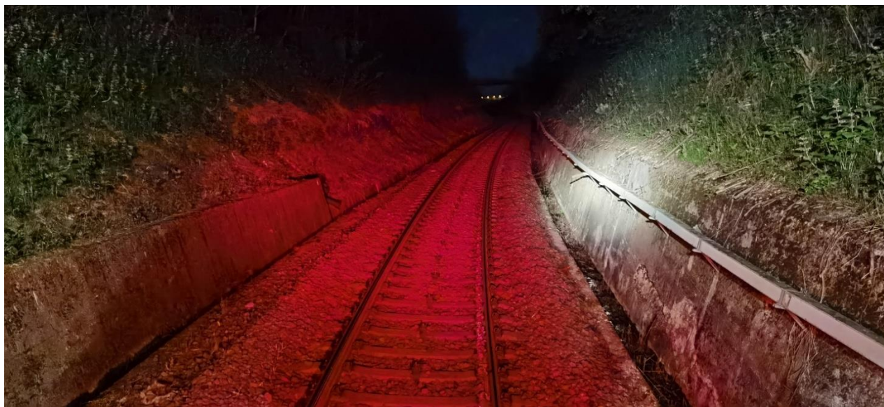
Figura 20: trincea tra le pk 139+155 e pk 139+449 – stato attuale
