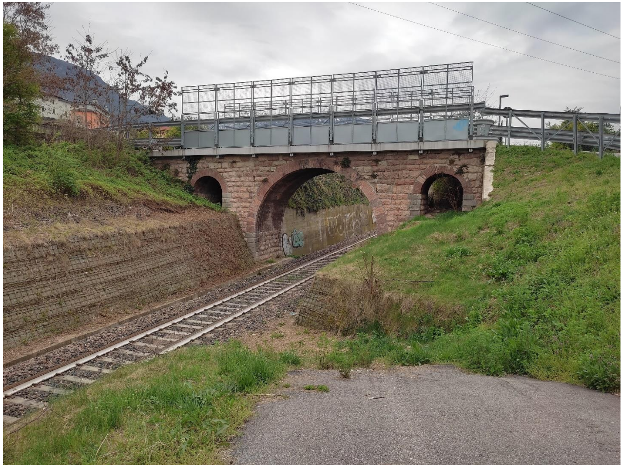
Figura 10: il cavalcavia San Bartolameo pkm 143+063 con l'accesso alla trincea ferroviaria
