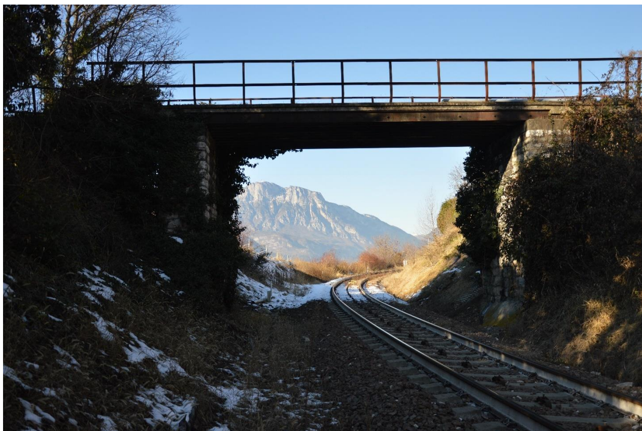
Figura 8: sovrappasso al km 138+728 Povo – stato attuale
