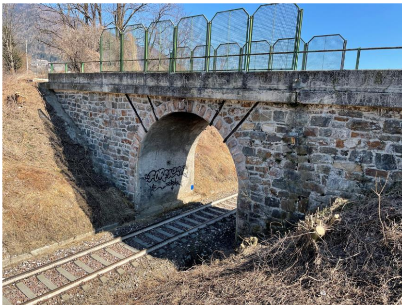
Figura 10:: Sovrappasso al km 117+362 Levico – Stato attuale
