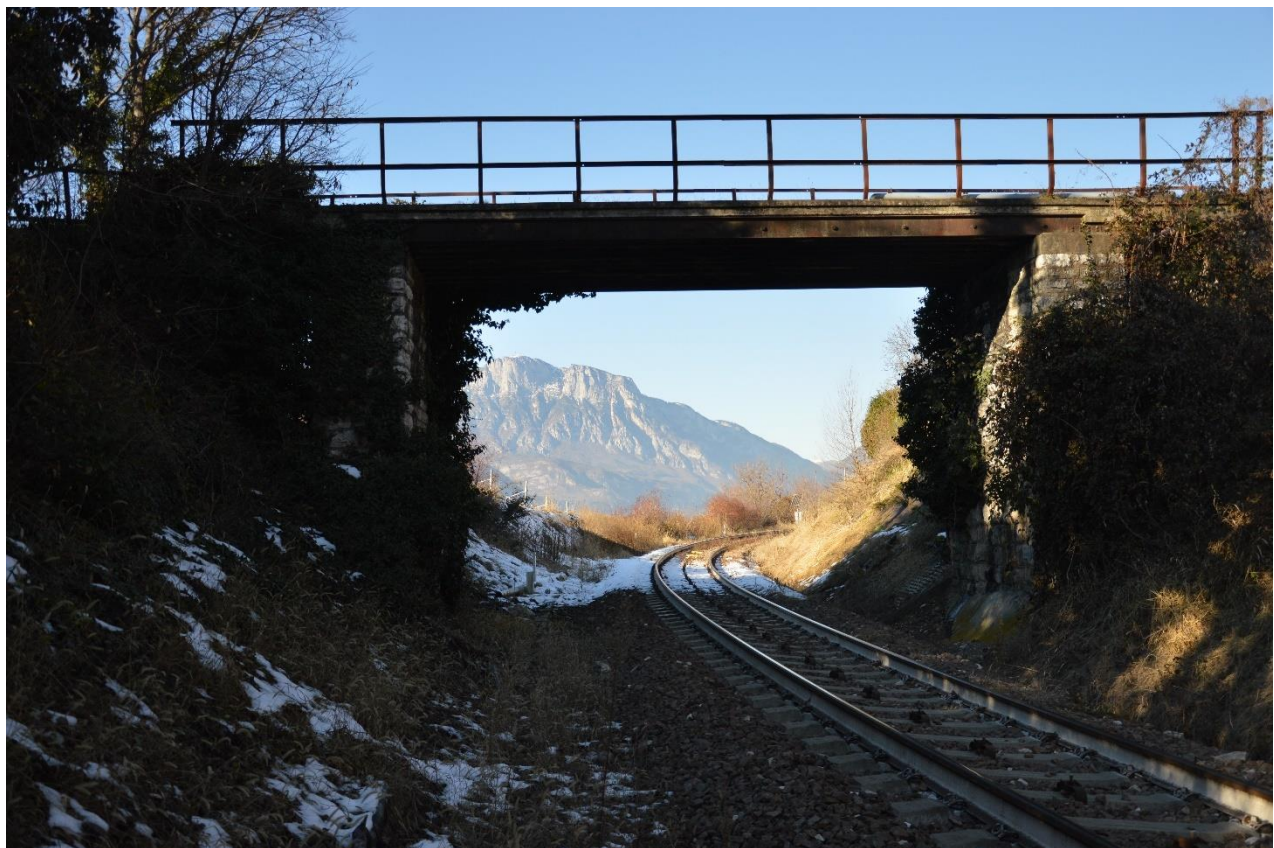
Figura 12: sovrappasso al km 138+728 Povo – stato attuale
