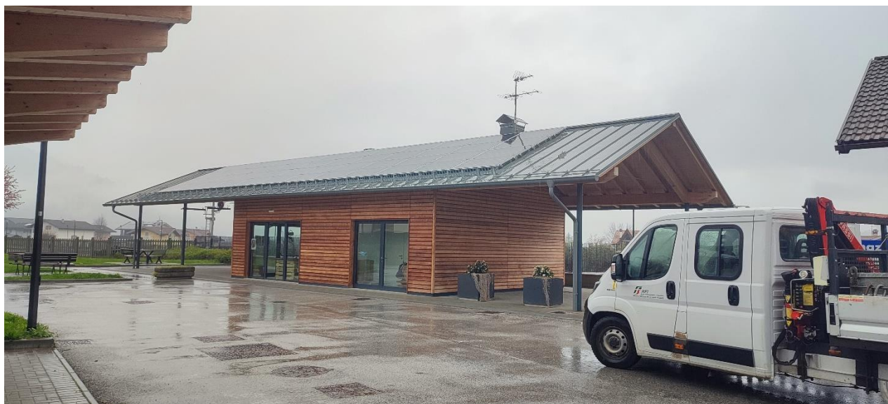
Figura 56: fabbricato commerciale Caldonazzo
