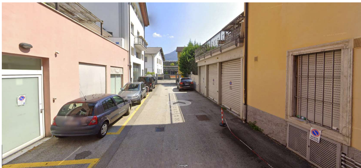
Vista ingresso all'area di cantiere
