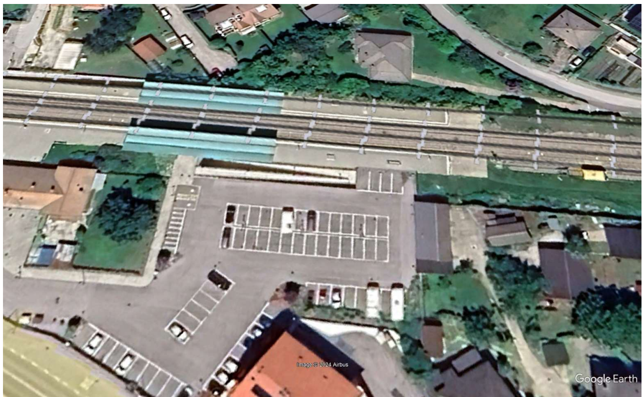
Vista aerea dell'area CO.03
