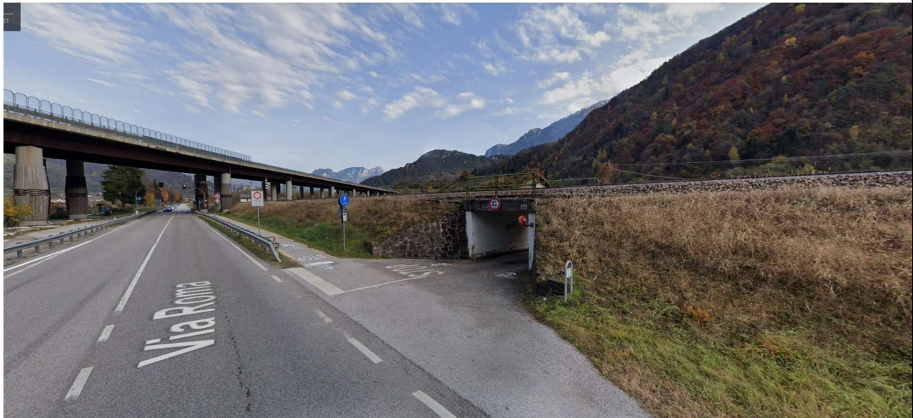
Vista della viabilità per l'accesso all'area.
