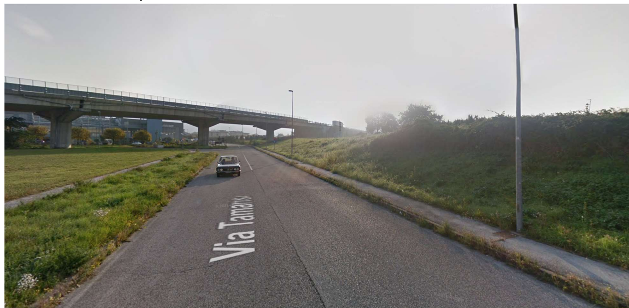
Vista della viabilità per l'accesso all'area.
