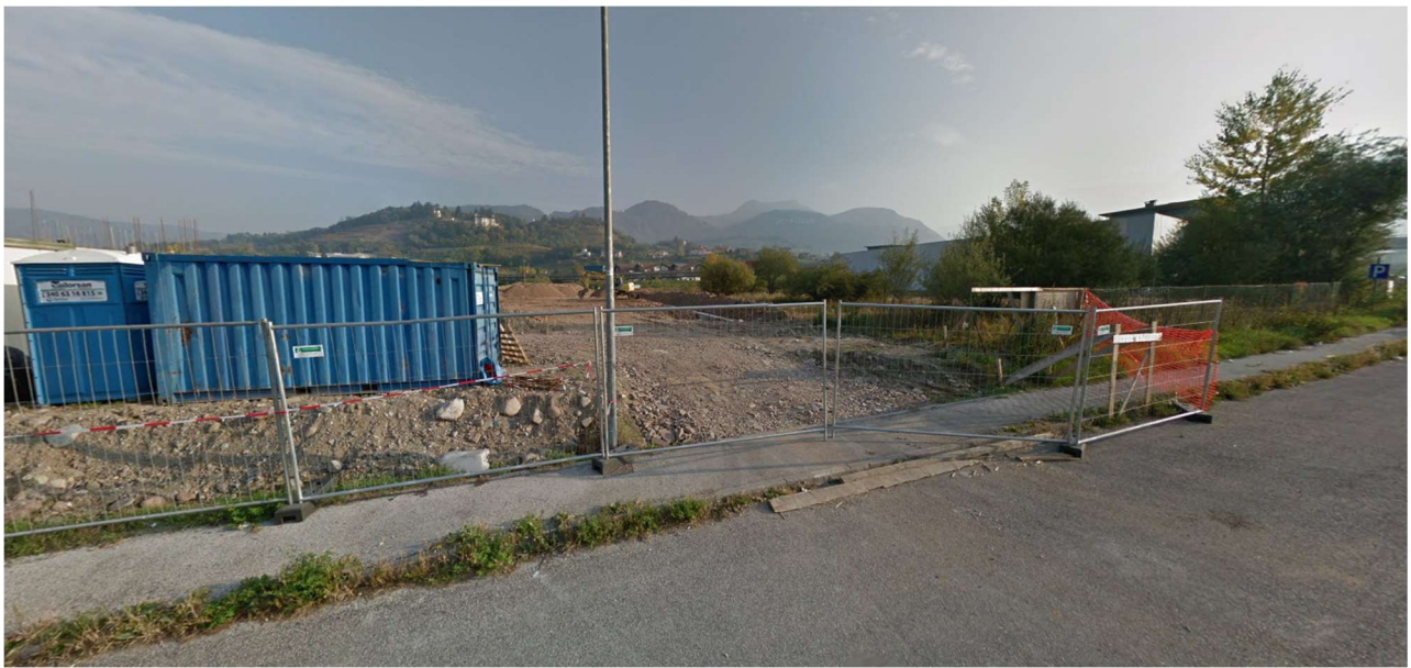
Vista viabilità accesso CO.02
