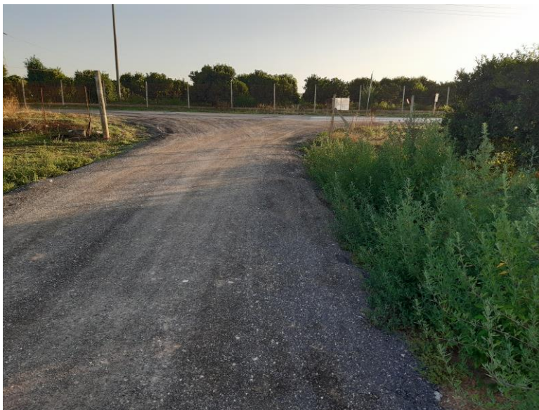
Figura 5 - Aree e percorsi in asfalto grezzo fresato non polveroso
