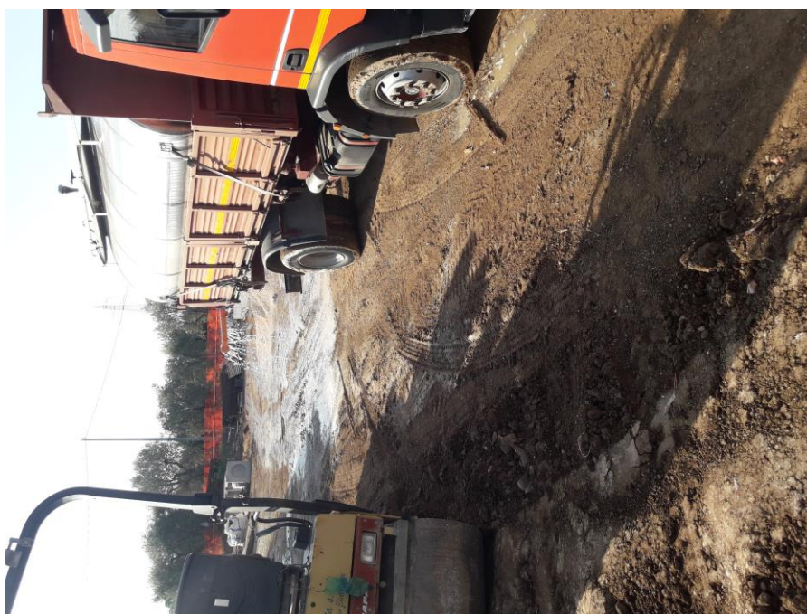
Figura 6 - Operazioni di battitura rullamento e bagnatura
