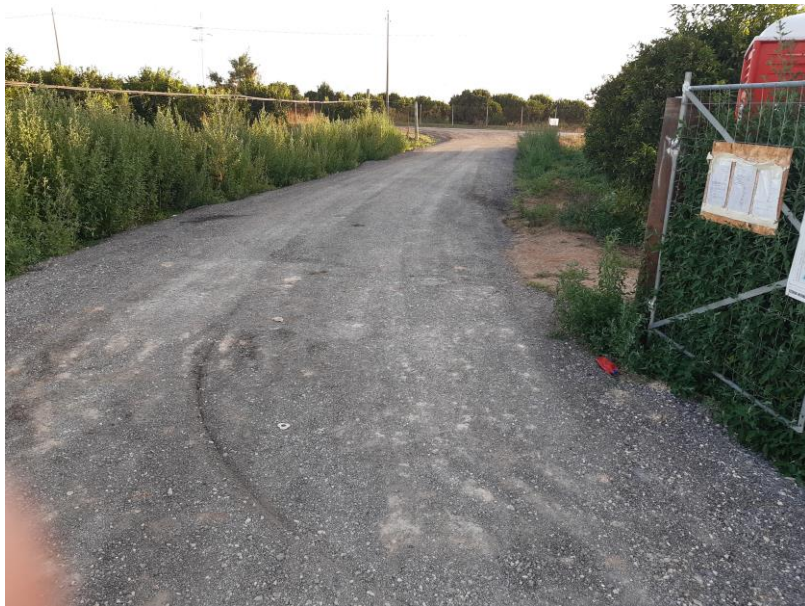
Figura 4 - Aree e percorsi in asfalto grezzo fresato non polveroso
