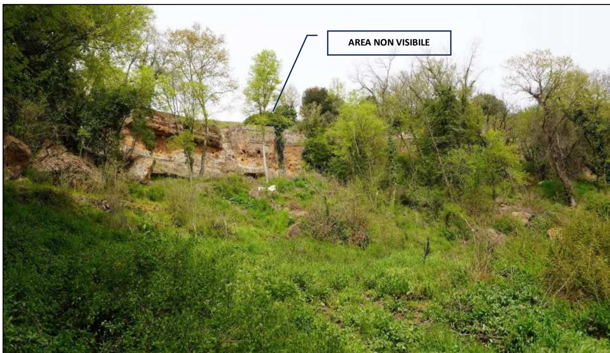
Punto di ripresa 03 – Stato di fatto
