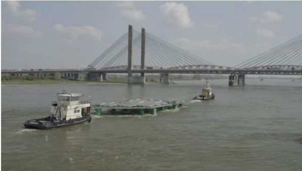
Figura 56: Trasporto in acqua della piattaforma triangolare
