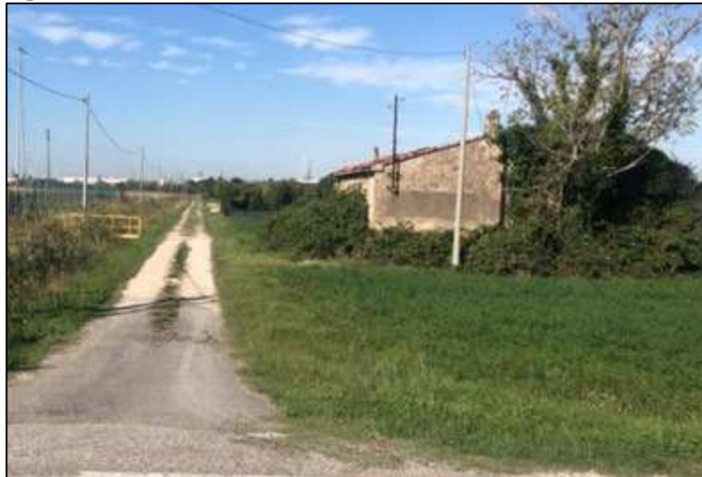
Figura 144: punto di criticità A lungo l'elettrodotto 380 kV
