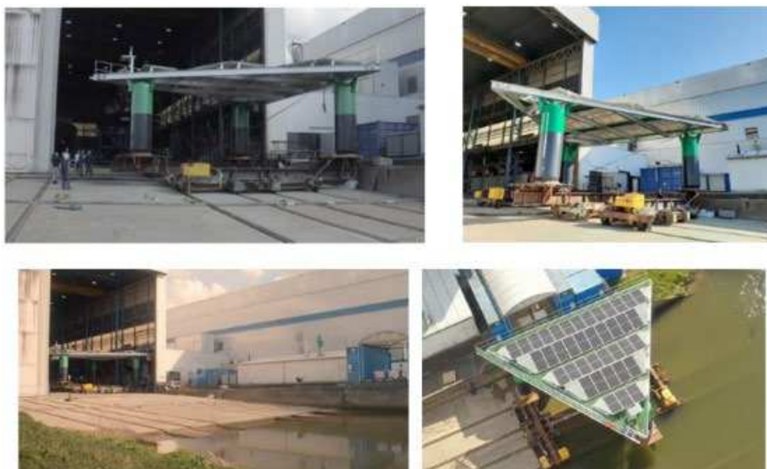
Figura 55: Trasporto in acqua della piattaforma triangolare
