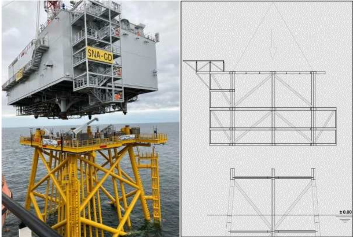
Figura 49: Installazione topside sottostazione
