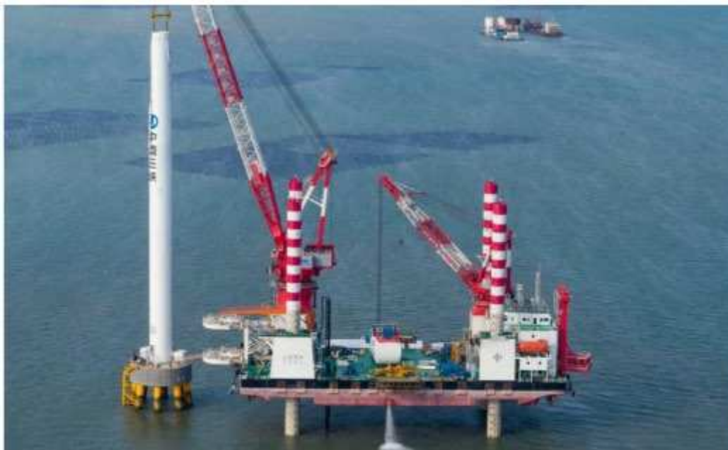
Figura 47: Esempio di installazione torre dell'aerogeneratore
