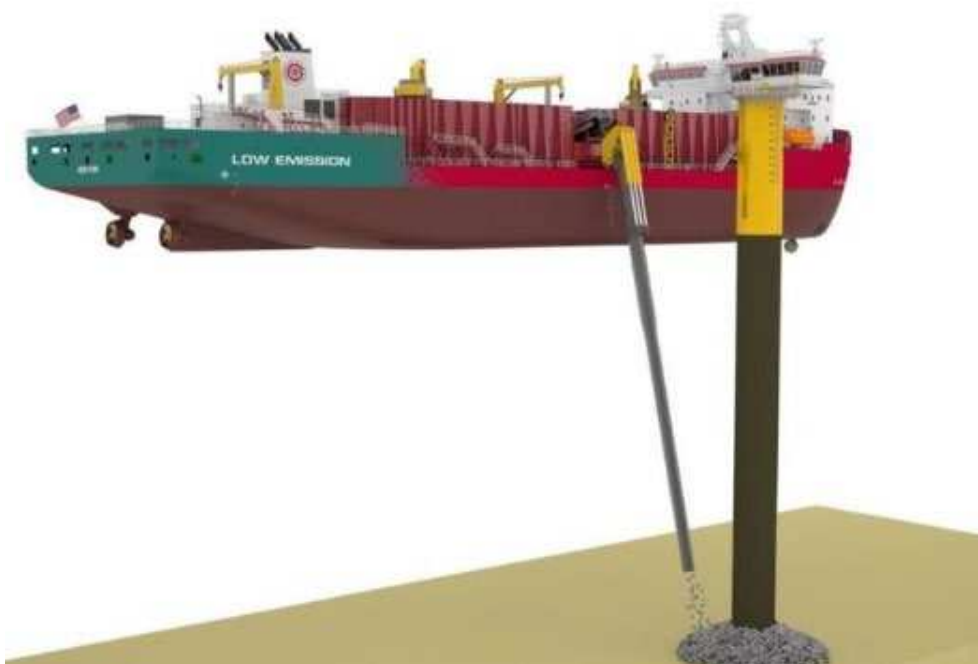
Figura 45: Esempio installazione di scour protection
