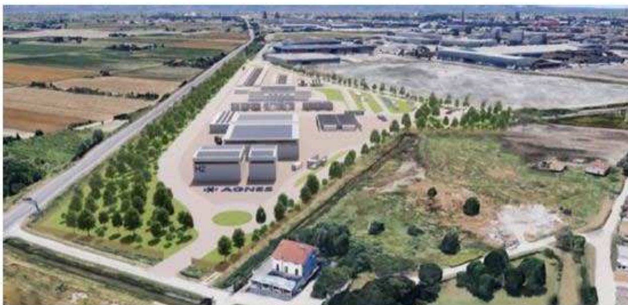
Figura 91: Immagine a volo d'uccello da nord dell'area Agnes Ravenna Porto durante la fase di esercizio
