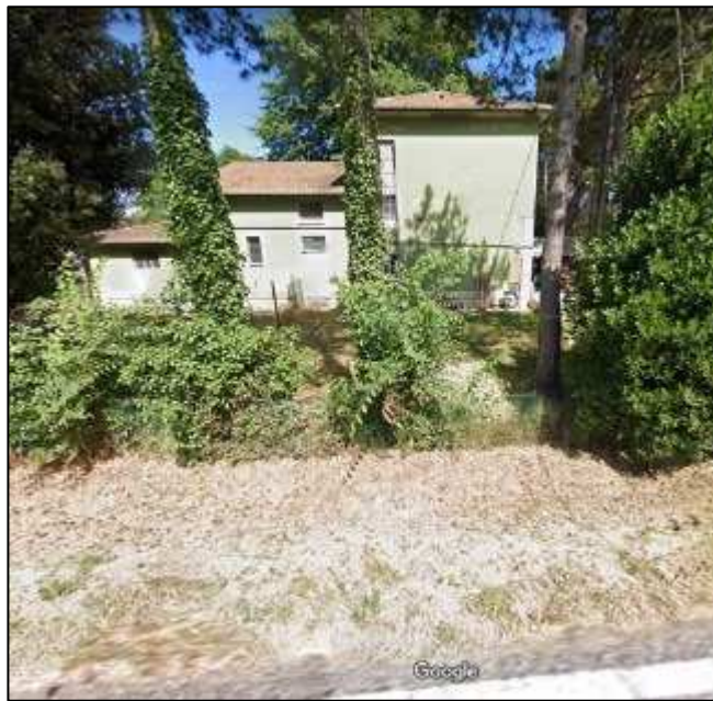
Figura 146: punto di criticità C lungo l'elettrodotto 380 kV
