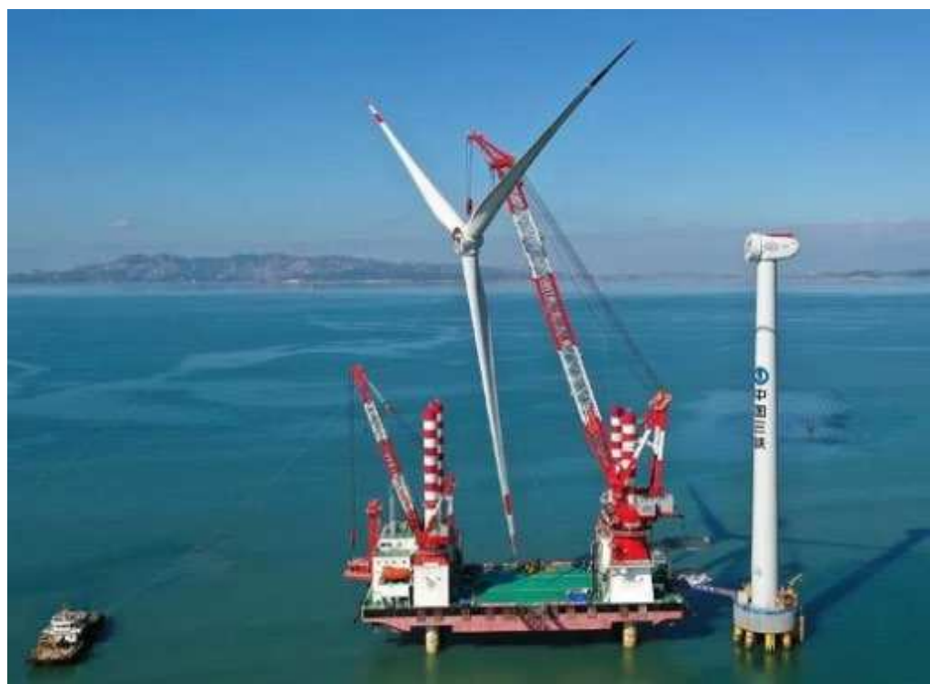
Figura 48: Esempio di installazione unità rotore e pale preassemblate
