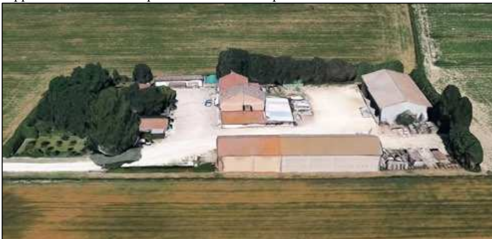
Figura 147: punto di criticità D lungo l'elettrodotto 380 kV
