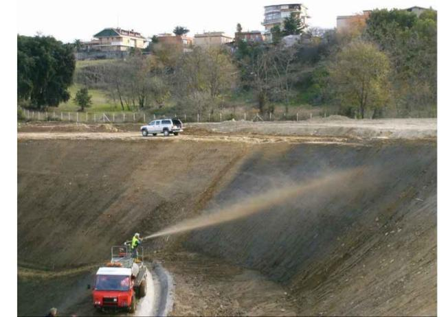
Per favorire il rinverdimento delle scarpate sarà utilizzata idrosemina con miscugli di sementi locali valutate in funzione delle quote di applicazione.
