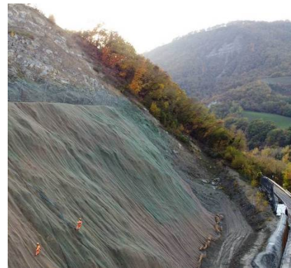
Sistema di applicazione idrosemina
