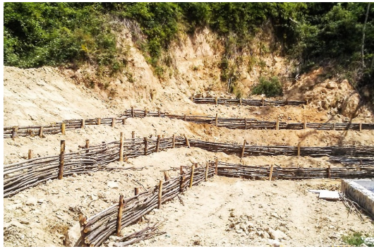
Esempio di realizzazione di una viminata
