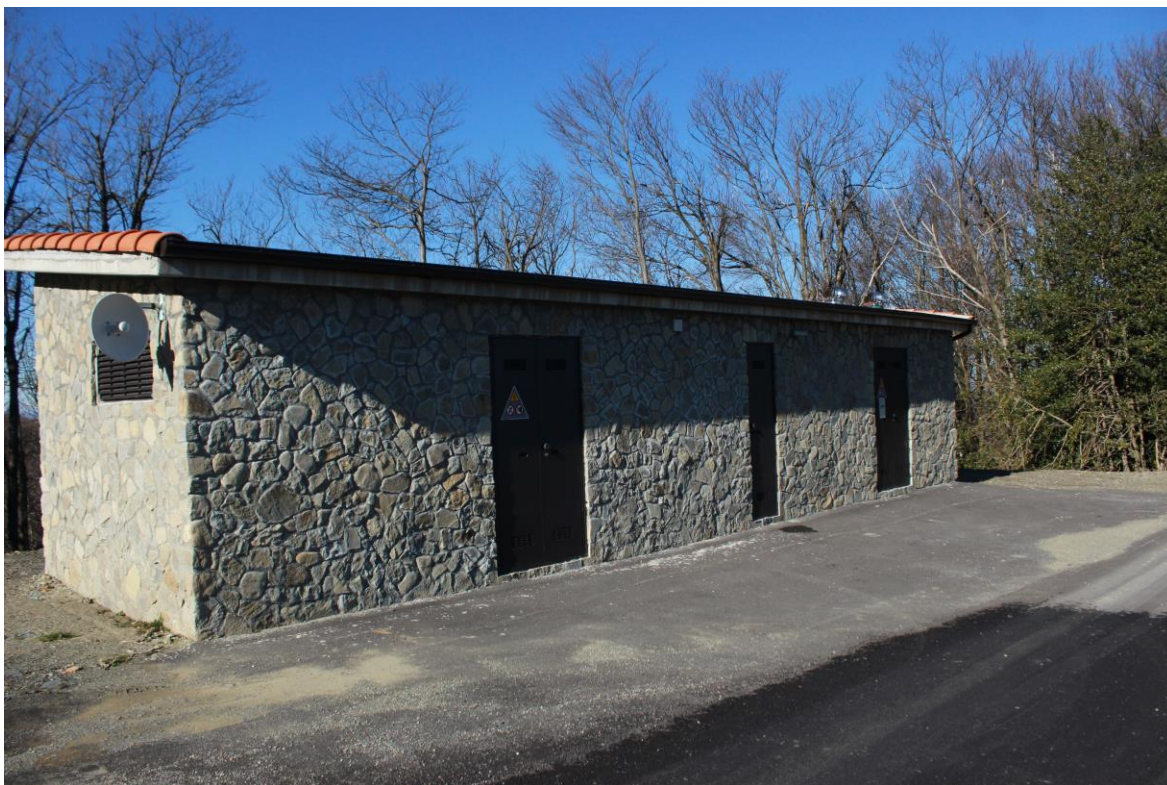
Esempio di cabina elettrica mitigata
