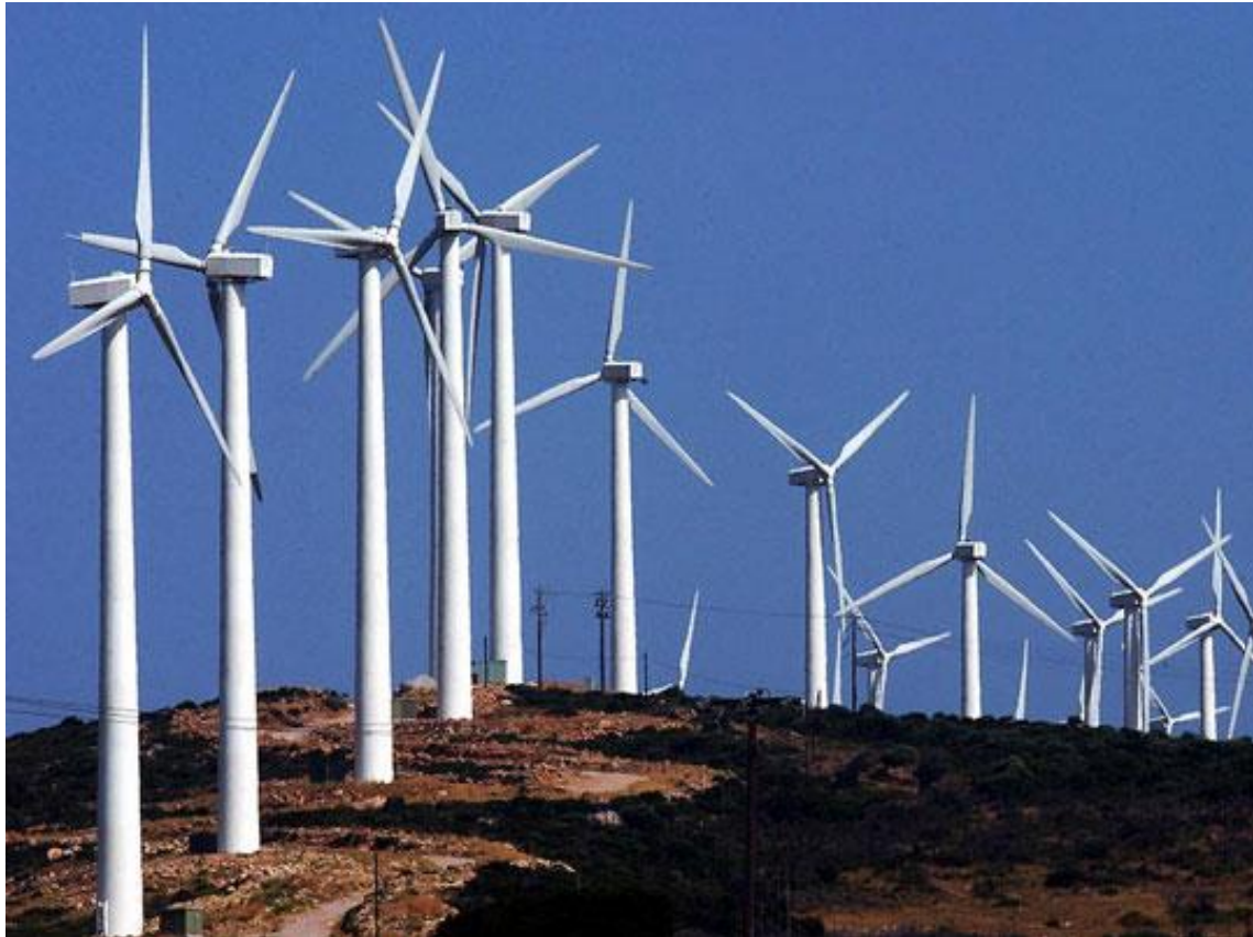
Panoramica impianto eolico con aerogeneratori di bassa potenza e minore altezza
