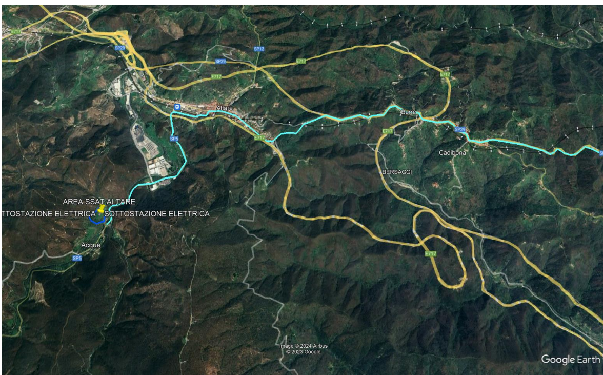
Tratto di connessione tra Cadibona e l'area della nuova sottostazione Terna
